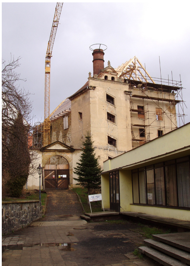
Obr. 3. Ústěck, městská památková rezervace, hrad pánů z Dubé, rekonstrukce kopie barokního krovu. Foto: Stanislav Flesar.
