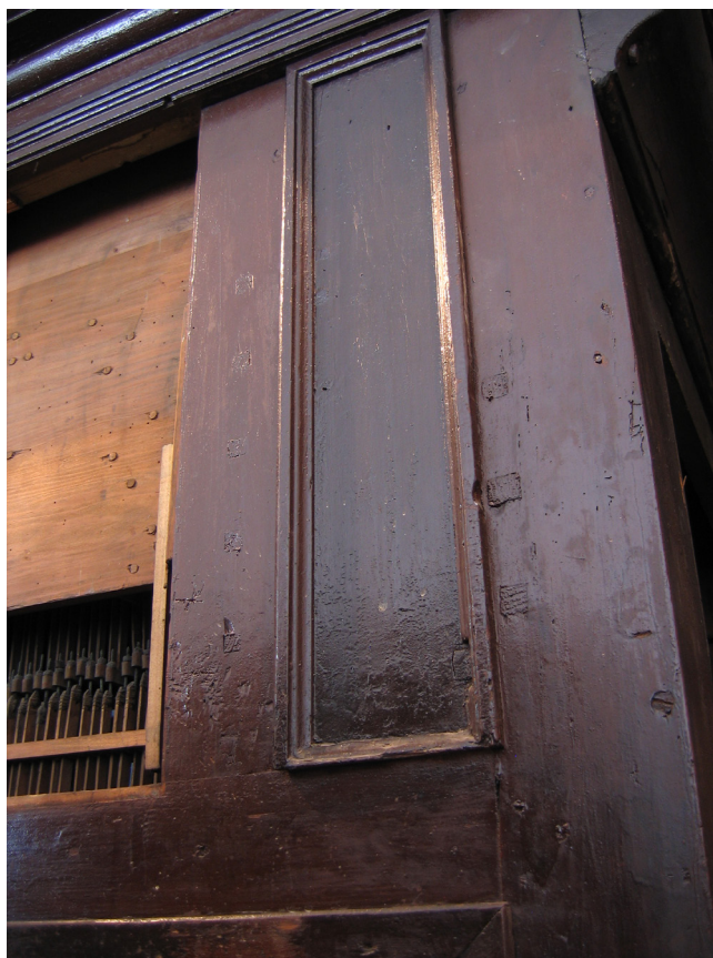
Obr. 9. Detail stop původních výřezů pro rejstříková táhla v postamentu. Foto: Eva Francová.
