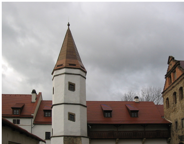
Obr. 6. Liboucheč, zámek, stav v průběhu obnovy. Foto: L. Černil.
