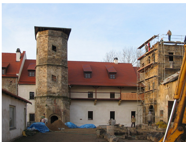
Obr. 3, 4. Liboucheč, zámek, stav v průběhu obnovy. Foto: L. Černil.
