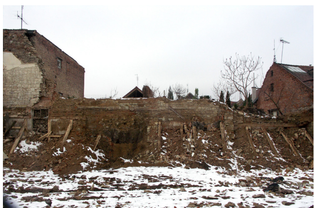
Obr. 6. Žatec, městská památková rezervace, hradba odhalená po demolicí objektu Střelnice s úseky datovanými dendrochronologickou analýzou do 2. třetiny 10. století. Foto: Lucie Radová.
