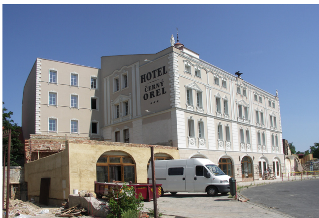
Obr. 5. Žatec, městská památková rezervace, Kruhové náměstí, dům čp. 233, nově provedená nevhodná „historizující“ fasáda na objektu sušárny chmele, adaptováno na hotel. Foto: Lucie Radová.
