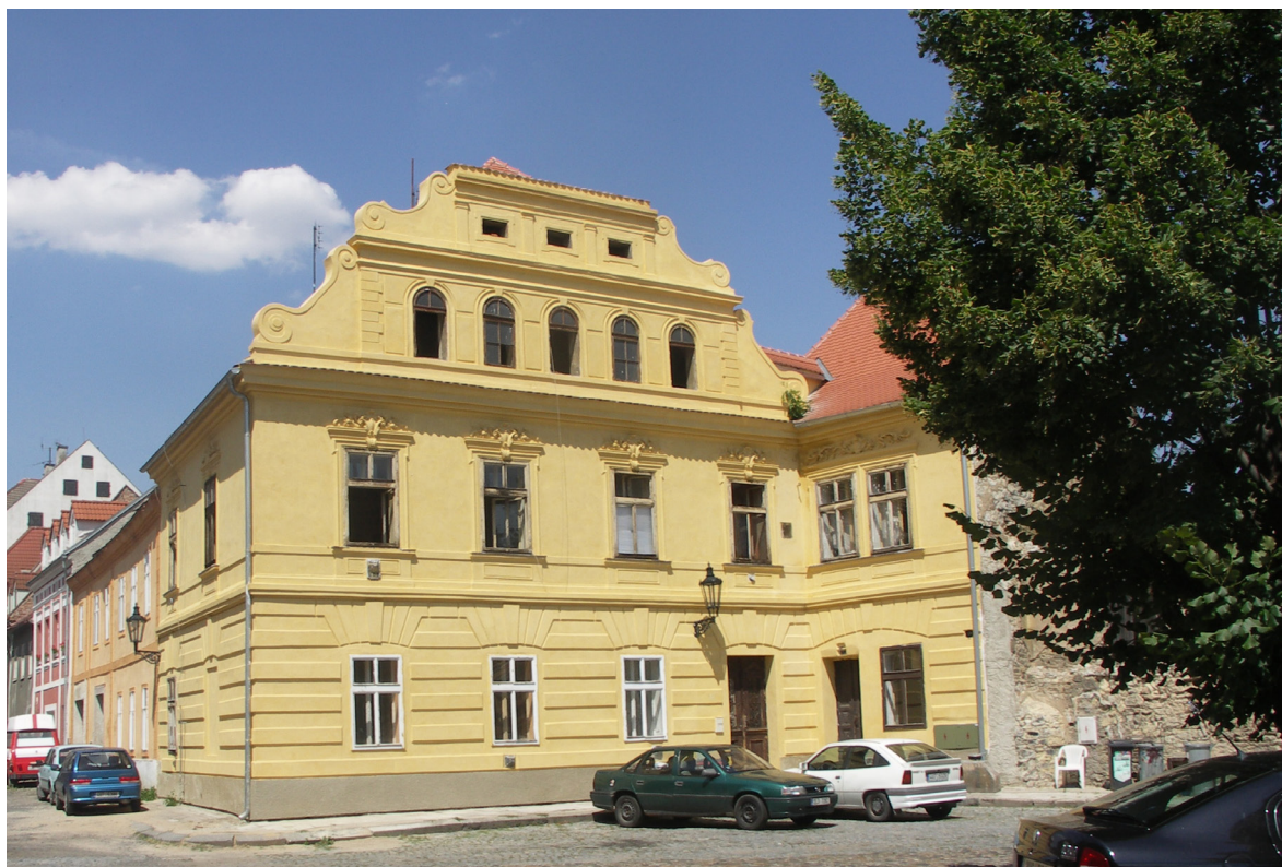
Obr. 2. Žatec, městská památková rezervace, nám. 5. května, dům čp. 101, obnovená fasáda s původní monochromní barevností z konce 19. století, použita byla vápenná technologie. Foto: Lucie Radová.
