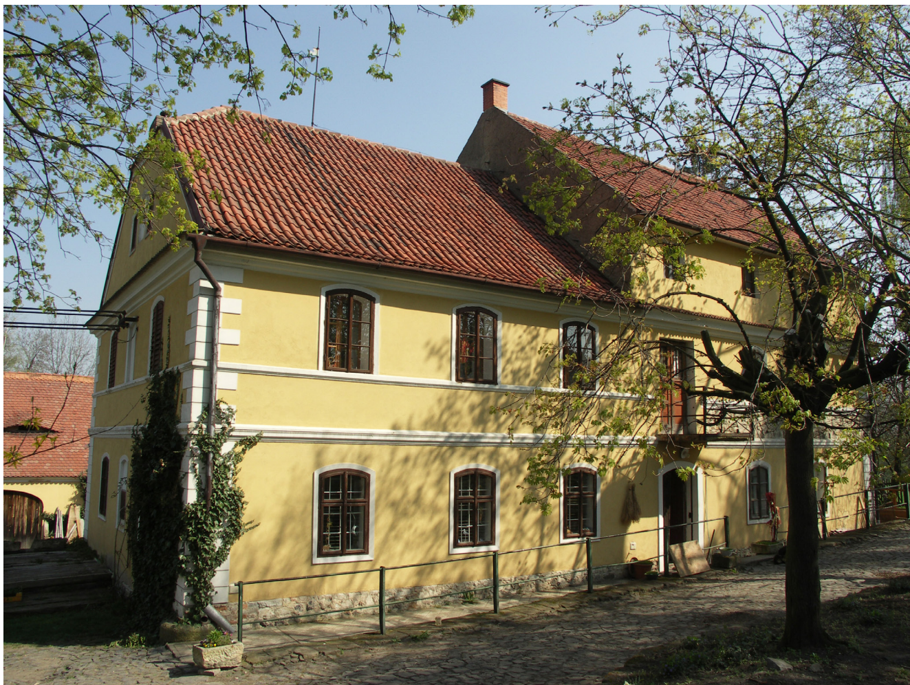
Obr. 1. Chodovlice č.p. 45, pohled od JZ. Foto: Jindřich Zajíc, 12. 4. 2009.
