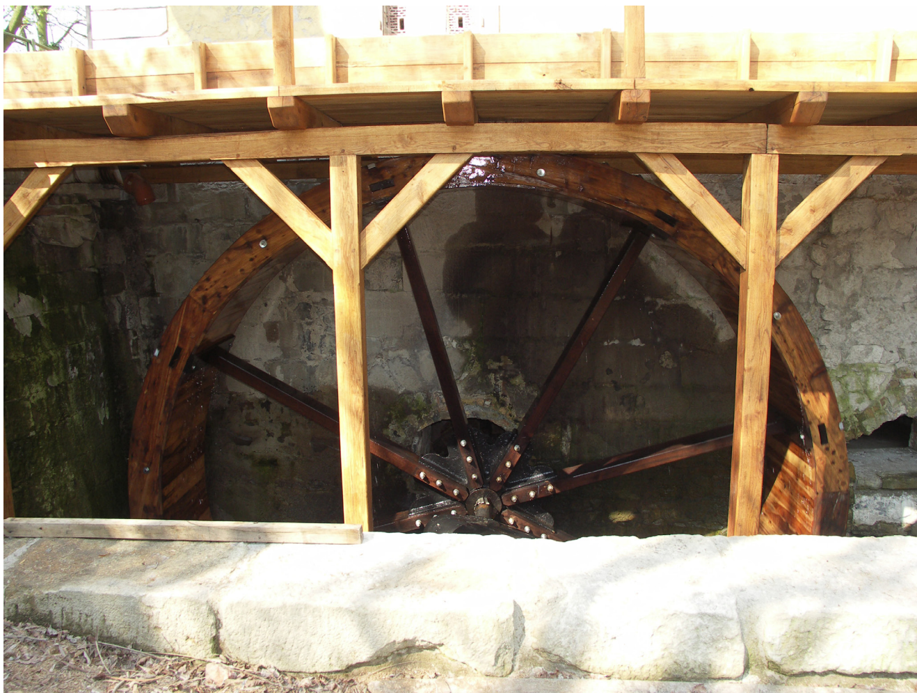
Obr. 4. Chodovlice č.p. 45, pohled od V na obnovené vodní kolo. Foto: Jindřich Zajíc, 12. 4. 2009.
