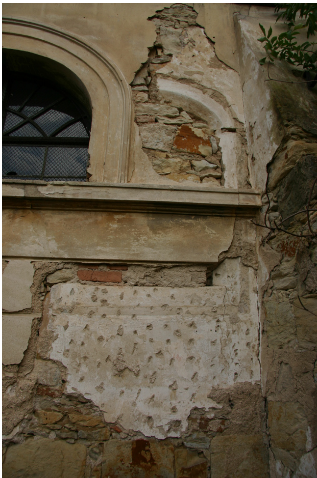
Obr. 3. Černěves, kostel sv. Prokopa, jižní průčelí presbytáře, superpozice okenních otvorů. Foto: Táňa Nejezchlebová 2009.
