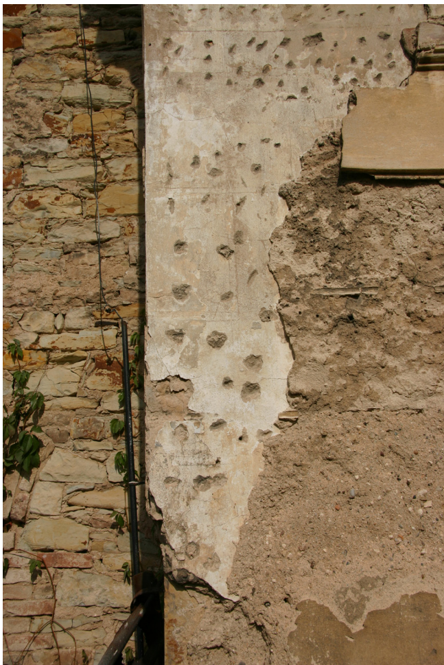
Obr. 6. Černěves, kostel sv. Prokopa, jižní průčelí lodi, detail rýsovaného nároží. Foto: Táňa Nejezchlebová 2009.
