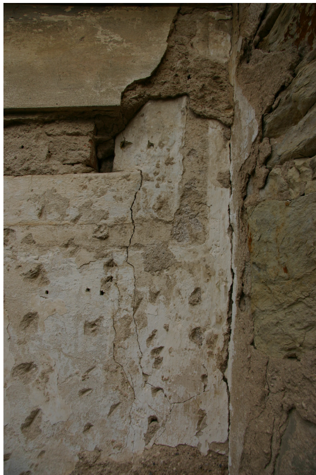
Obr. 4. Černěves, kostel sv. Prokopa, jižní průčelí presbytáře, detail zpracování škrábané pasparty starších okenních otvorů presbytáře. Foto: Táňa Nejezchlebová 2009.
