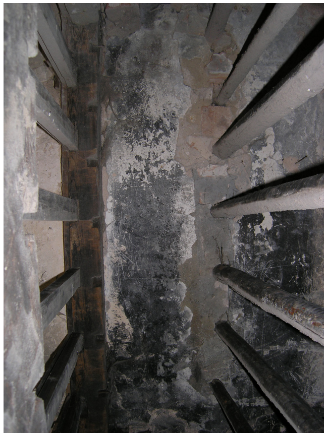
Obr. 6. Detail se stopami po výměně bidel a přestavbě rámu. Foto: Kamil Podroužek.
