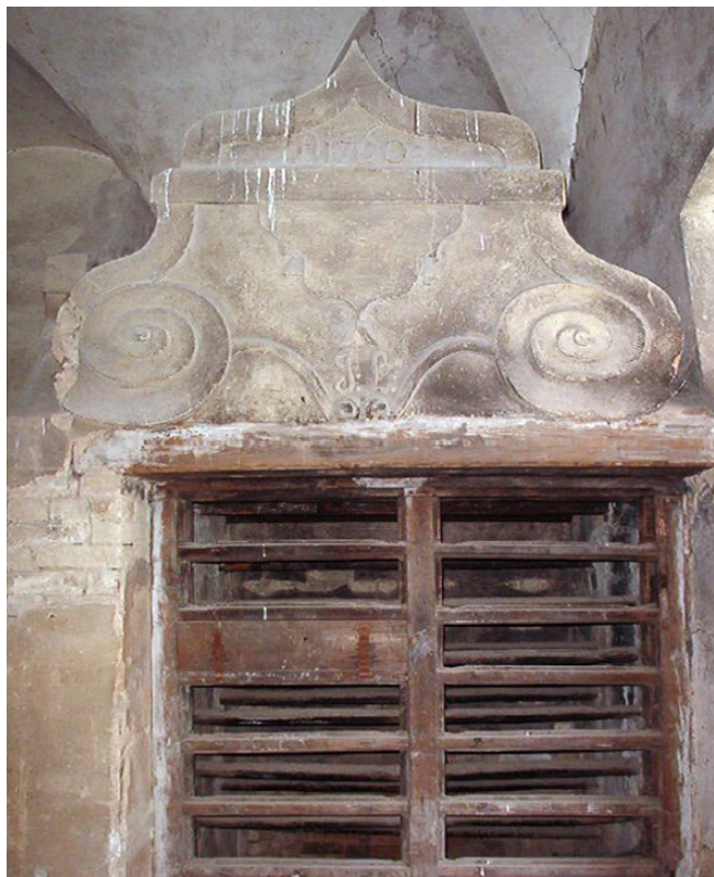
Obr. 5. Rám s párovými okénky pro zasunutí lísek. Foto: Kamil Podroužek.
