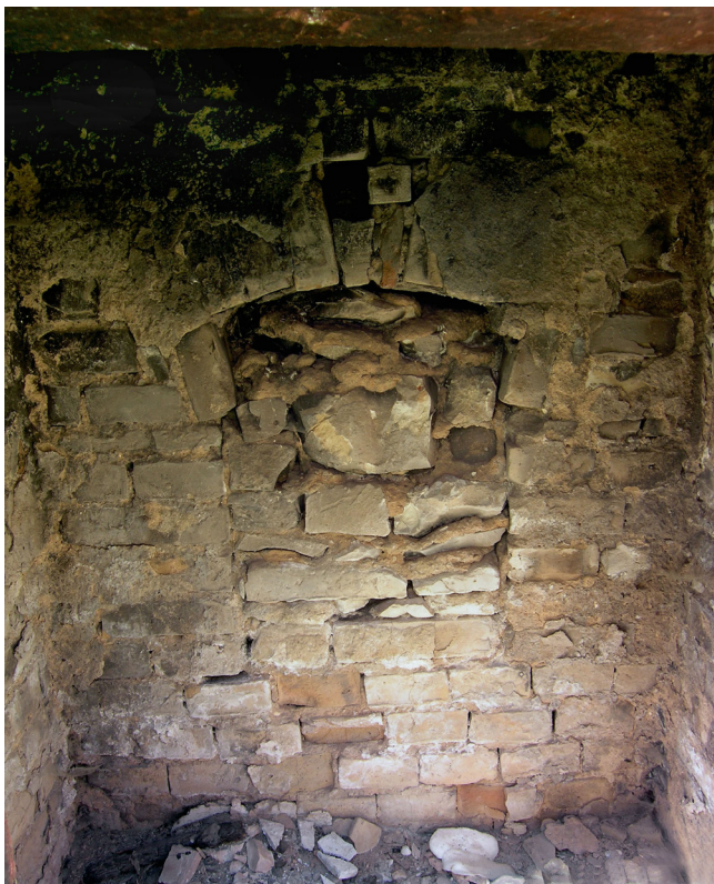
Obr. 7. Detail zazděného vytápěcího otvoru otočeného do vstupního průčelí severního křídla. Foto: Kamil Podroužek.
