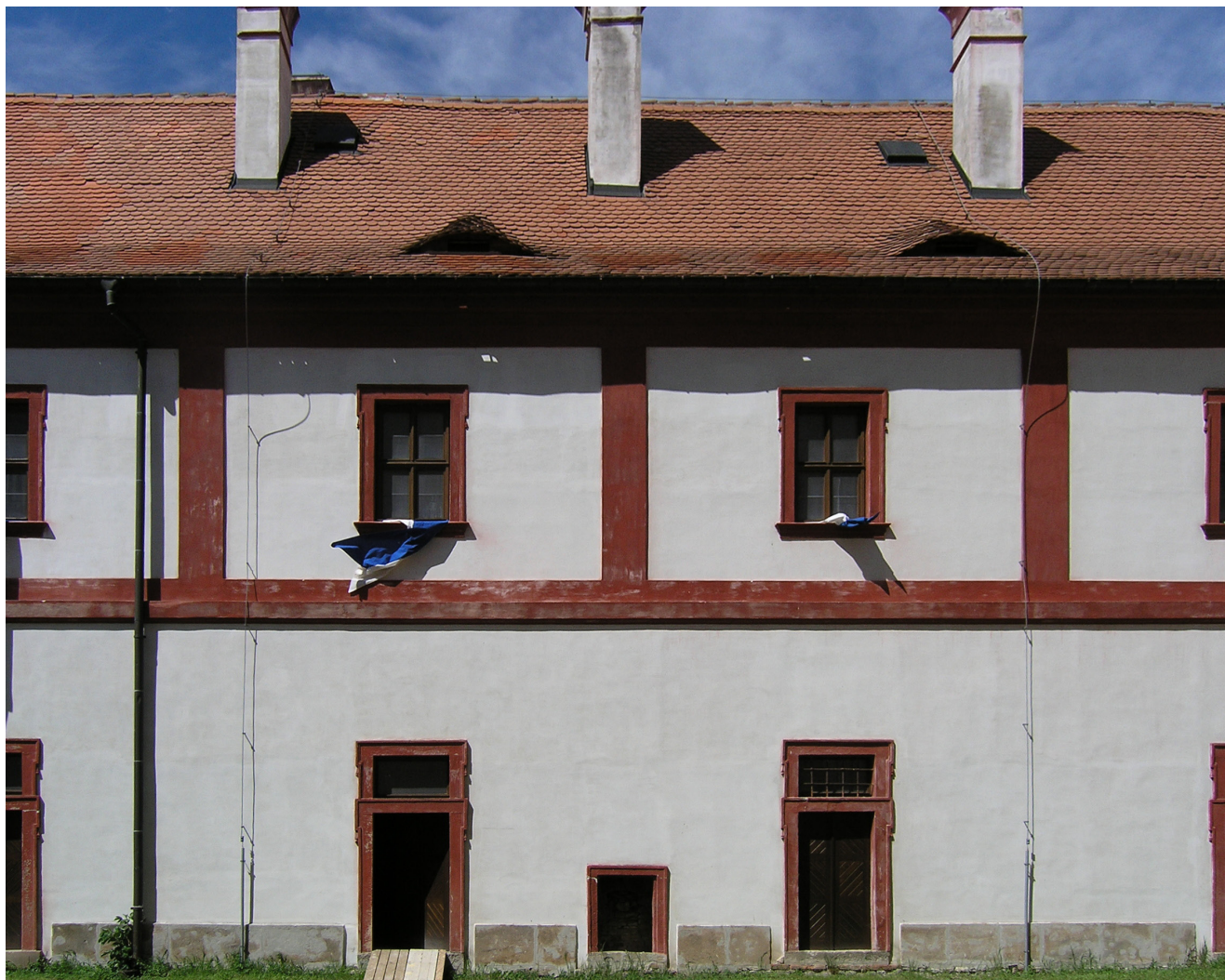
Obr. 1. Situace vstupu do sušárny ovoce a nakládacího otvoru topeniště v průčelí severního křídla. Foto: Kamil Podroužek.
