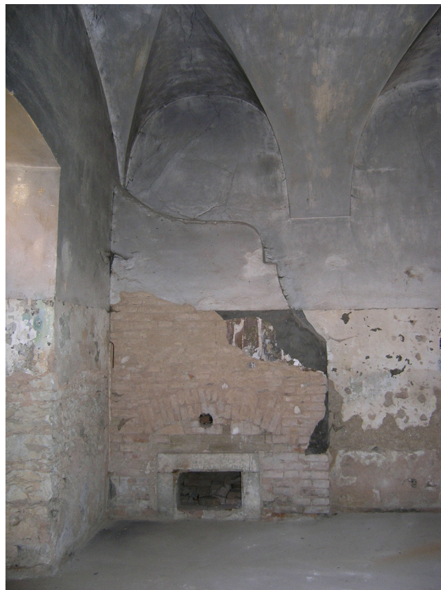
Obr. 8. Detail přízděného komínového sopouchu a nakládacího otvoru otočeného do sousední východní místnosti. Foto: Kamil Podroužek.
