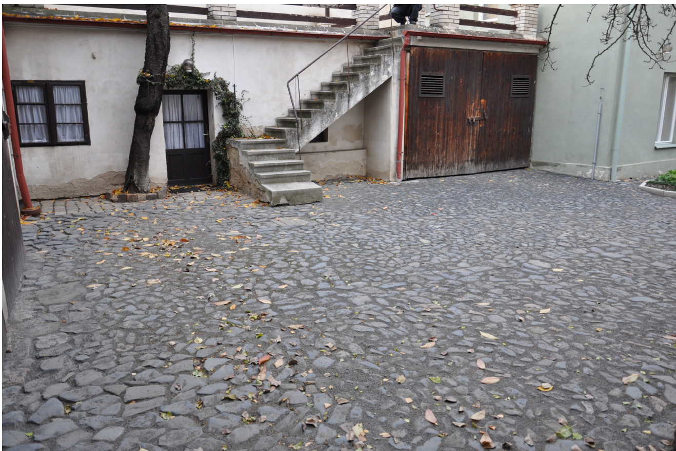
Obr. 1. Terezín, dvůr u domu č.p. 17, Dlouhá ul. Nově položená kamenná dlažba z nepravidelného čedičového kamene kladená na divoko s diagonálně vedenou podélnou stružkou pro odvedení dešťové vody. V SZ nároží u vstupu do modlitebny vějířovitá skladba z křemencových štípaných valounů. Foto: Jan Peer.
