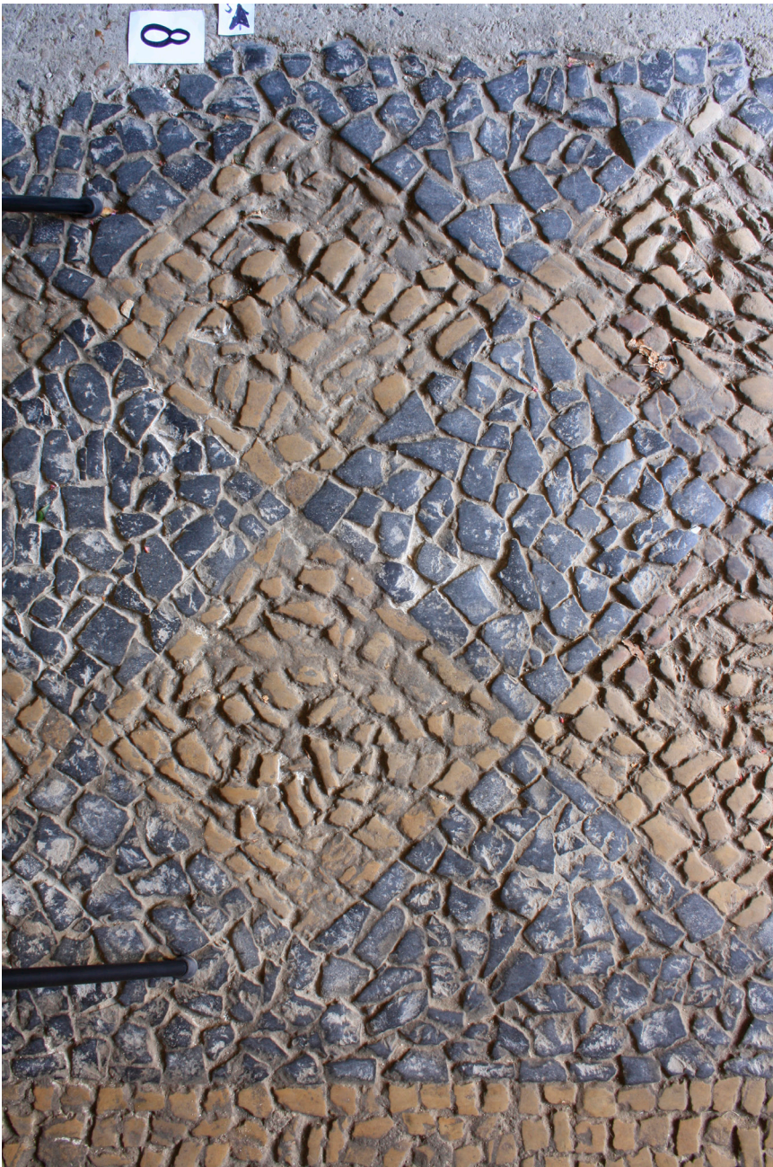
Obr. 5. Terezín, průjezd domu č.p. 131, Dlouhá ul. Detail zabláždění. Foto: Jan Peer.
