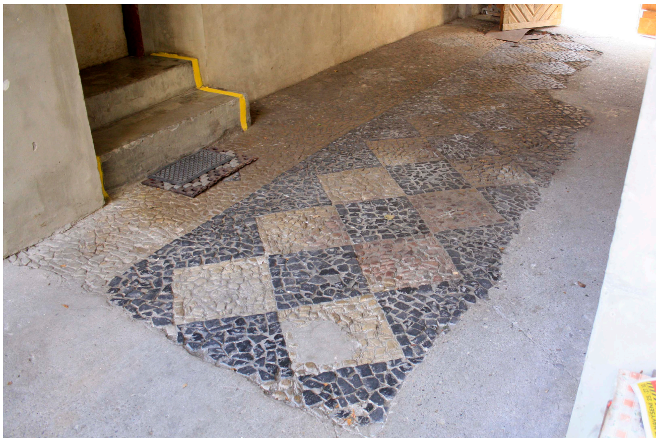
Obr. 4. Terezín, průjezd domu č.p. 131, Dlouhá ul. Ojedinelý typ zachované mozaikové dlažby. Průjezd členěn na tři pásy vedoucí v ose průjezdu. Střední pás o šíři cca 140 cm tvoří střídavě čedičové a křemencové čtverce (vel. 40 x 40 cm) orientované na koso vůči ose průjezdu. Jižní pás o šíři 90 – 100 cm z nepravidelně vyskládaných křemencových štípaných kamenů doplněný dvojicí čedičových kosočtverců (40 x 40 cm). Severní pás tvoří dnes druhotně provedený překryv z betonové mazaniny – fragmentálně vystupují křemencové a čedičové kameny bez struktury vzoru. Jedná se o jednu z nejkvalitněji provedených dlažeb v Terezíně. Srovnatelné jsou pouze dvě dochované dlažby ve městě, a to v objektu Dolní vodní brány a průjezdu domu č.p. 223 v ulici Dlouhá). Díky identickému použití stavebního materiálu i obdobnému řemeslnému zpracování lze vznik dlažeb řadit do shodného časového období. Usuzujeme, že se jedná o práci jednoho autora, příp. řemeslné skupiny. Velmi pravděpodobně se jedná o práci provedenou v poslední třetině 19. století, kdy byly mozaikové dlažby z nepravidelných kamenů v oblíbě i v periferních oblastech. Foto: Jan Peer.
