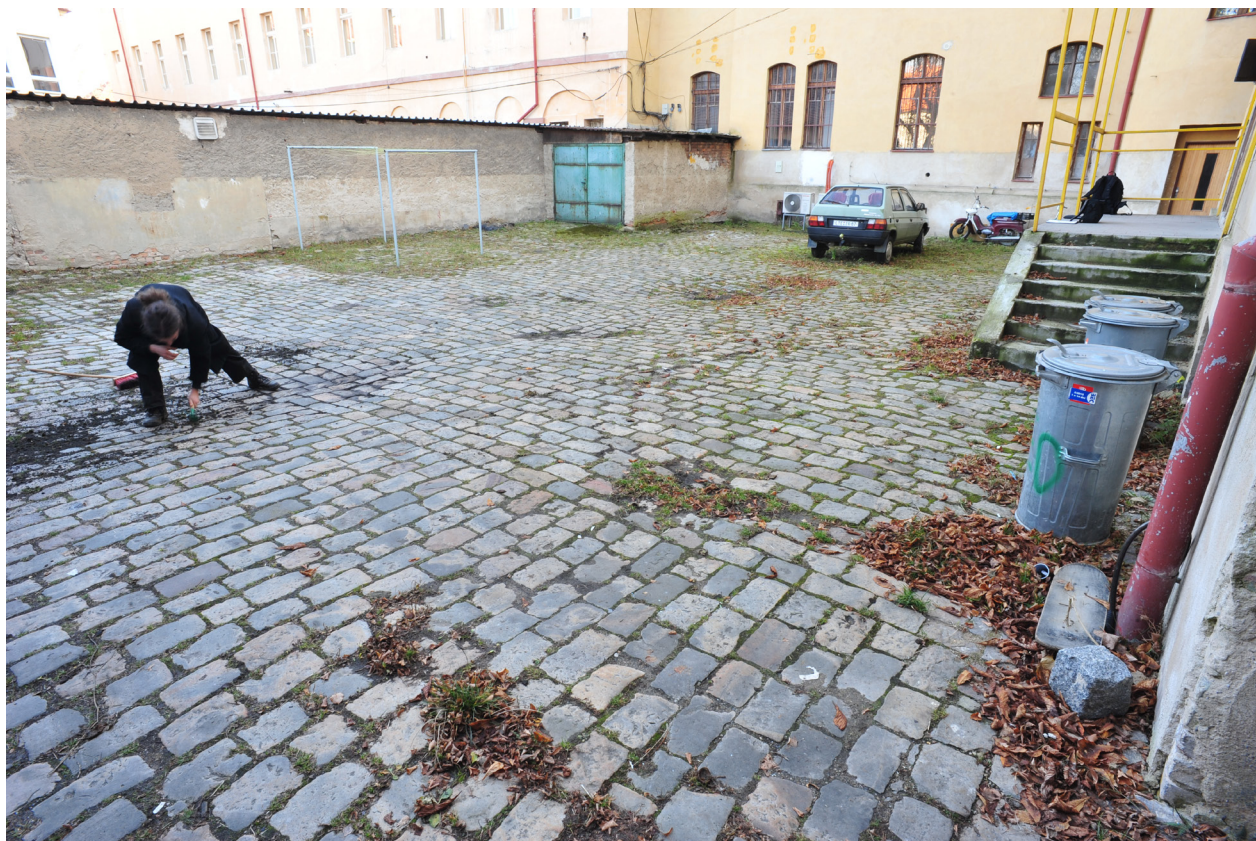
Obr. 9. Terežín, dvůr u domu č.p. 178, nám. ČSA. Plocha dvora zadlážděna z opracovaných křemencových hranolů zhruba stejné šířky, kladených do řádků. Plocha je členěna na tři celky: pás dlažby v severní části nádvoří o šíři průjezdu z ulice Máchova o šíři 3 m – řádky kostek jsou orientovány rovnoběžně s osou průjezdu (sever – jih). Zbytek nádvoří v řádkové skladbě východ – západ je členěn úžlabím o dvou řadách kostek na dvě přibližně stejně velké plochy. Je patrný mírně vyduťtý profil povrchu dlažby. Křemencové kameny jsou místy nahrazeny čedičovými, příp. žulovými opracovanými kameny stejných rozměrů. Foto: Jan Peer.
