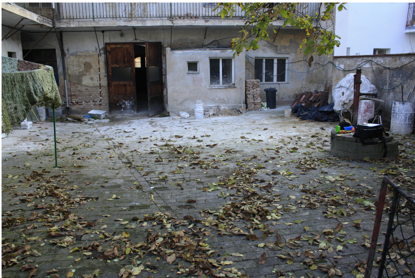
Obr. 2. Terežín, dvůr objektu č.p. 22, Dlouhá ul. Cihlová dlažba z cihel s odtokovou strouhou z jednoho řádku cihel diagonálně přes celou plochu dvora. Foto: Jan Horák.
