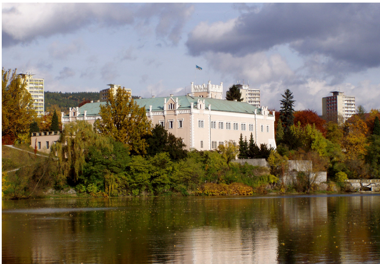
Obr. 1. Klášterec nad Ohří, zámek, stav před obnovou fasád, 2005. Foto: Jan Koloc.
