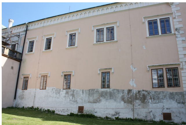
Obr. 3. Klášterec nad Ohří, zámek, jihovýchodní průčelí, stav v průběhu škrábání fasádního nátěru, 2010. Foto: Martin Zubík.
