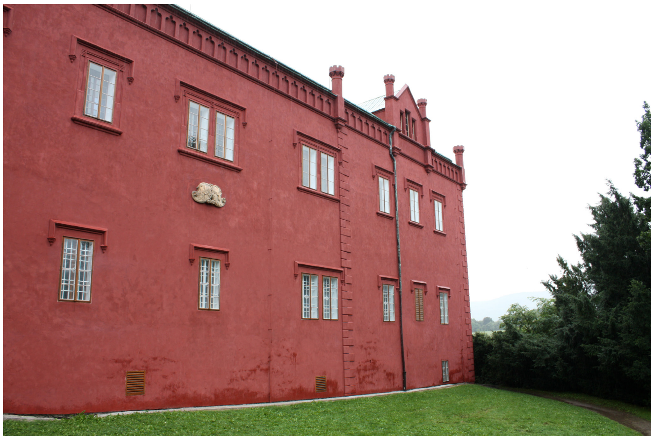
Obr. 4. Klášterec nad Ohří, zámek, jihovýchodní průčelí, stav po obnově fasád, 2010. Foto: Martin Zubík.
