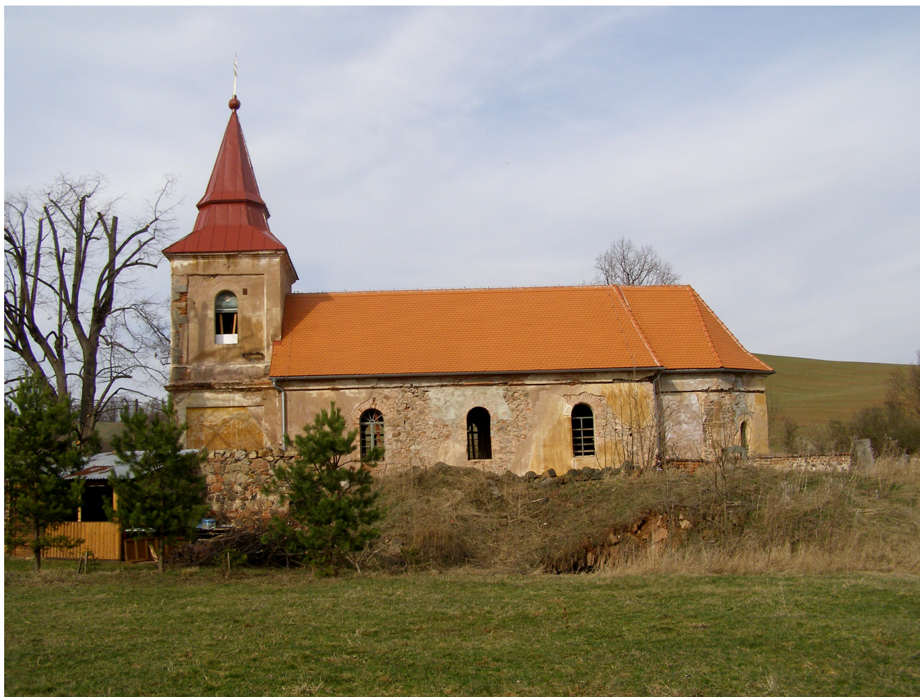
Obr. 2. Libyně, kostel sv. Jiljí, celkový pohled od J. Foto: Jan Koloc, 25. 3. 2010.
