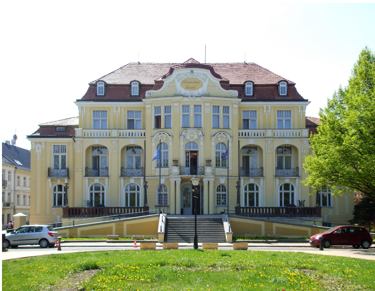
Obr. 8. Lázně Císařovny Alžběty, dnes Kamenné, realizováno dle plánů Gustava Jirsche a Edmunda Arnima, 1902–05. Foto: autor, 04/2012.
