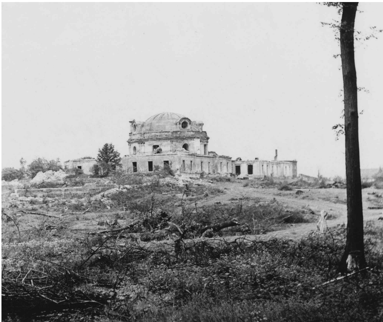
Obr. 13. Demolice špitálu v roce 1958, MMD, Barokní památky v Duchcově (špitál a kaple sv. Barbory), S–XXXII, fotografie, nedat., sine pag.
