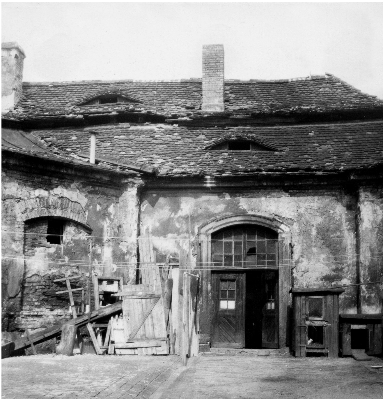
Obr. 11. Pohledy na zchátralé části špitální budovy, MMD, Barokní památky v Duchcově (špitál a kaple sv. Barbory), S–XXXII, fotografie, nedat., sine pag.
