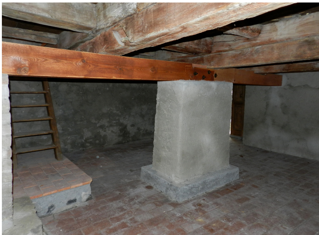
Obr. 3. Dlažkovice, areál kostela sv. Václava – zvonice, pohled do interiéru obnoveného přízemí zvonice. Foto: Jindřich Zajíc, březen 2012.
