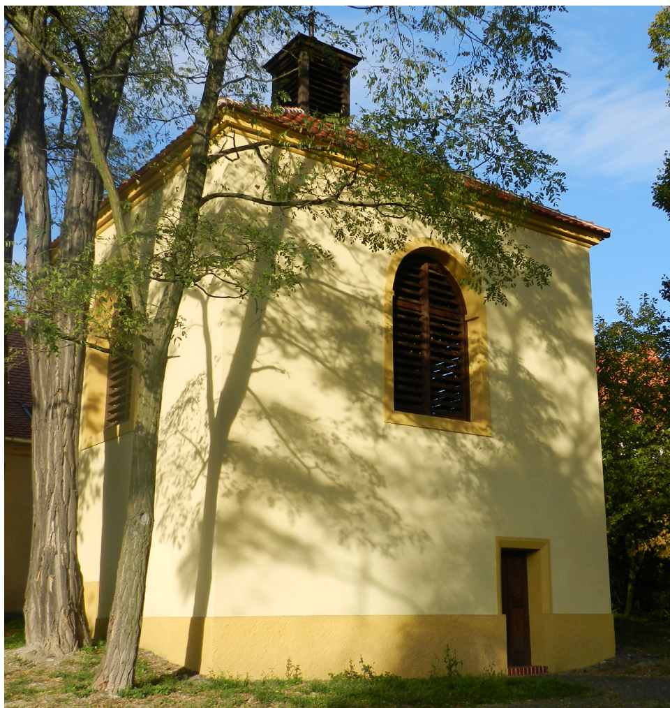
Obr. 2. Dlažkovice, areál kostela sv. Václava – zvonice, pohled od jihozápadu, stav po obnově. Foto: Jindřich Zajíc, říjen 2012.
