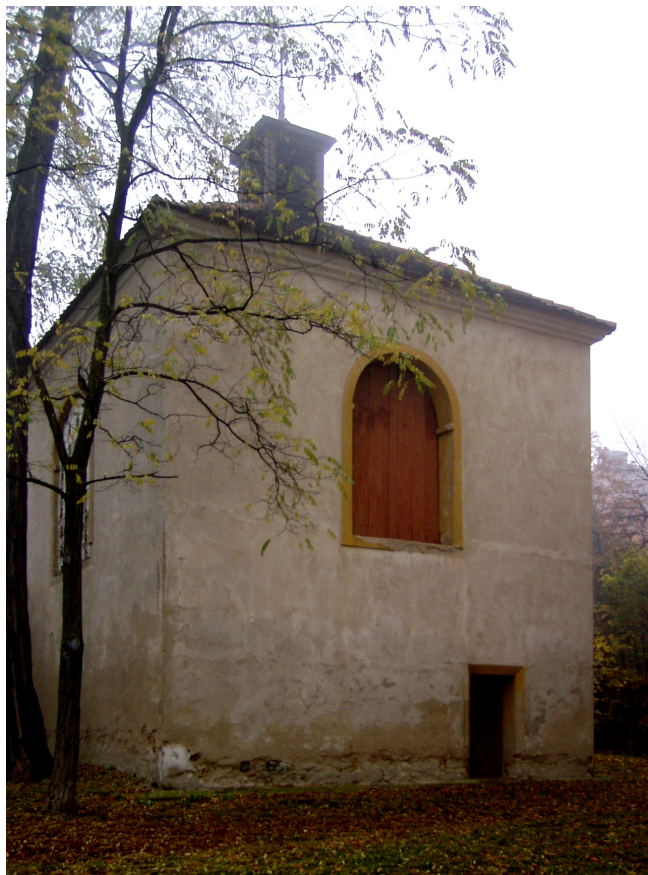
Obr. 1. Dlačkovice, areál kostela sv. Václava – zvonice, pohled od jihozápadu, stav před obnovou. Foto: Jan Koloc, září 2009.
