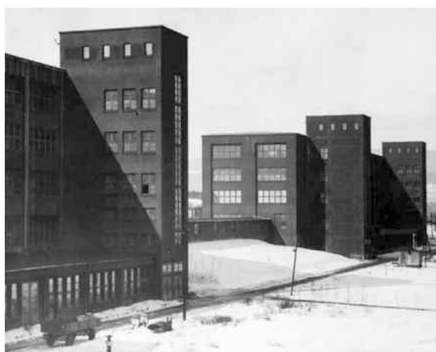
Obr. 31. Etážovka Fein Apparaten Bau, Franz Anton Dischinger, Dywidag, 1939–40. SOka Litoměřice – Most, fond AF 104 FAB, kt. 4.
