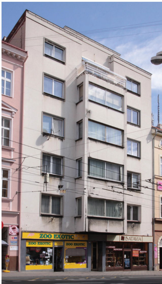
Obr. 12. Bytový dům Školní č. p. 408, Ernst Kominik, 1933. Foto: Marta Pavlíková, 2009.
