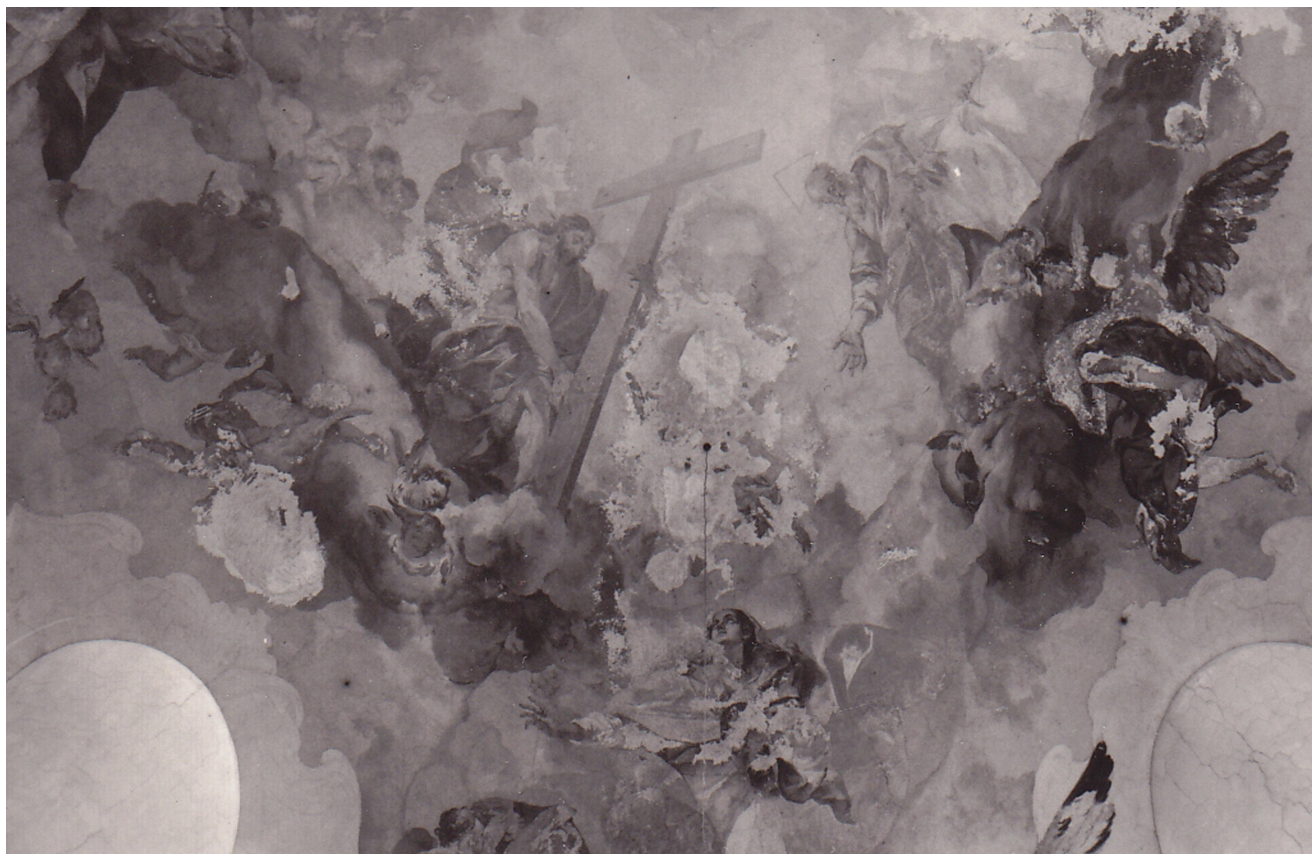
Obr. 9. Stav Reinerovy fresky před sejmutím v roce 1956, detail lokálních poškození, NPÚ ÚOP v Ústí nad Labem, odborná spisovna, restaurátorská zpráva č. 494/R, fotografie, sine pag.
