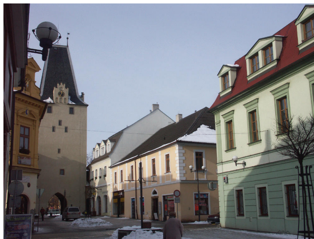
Obr. 5. Stav objektu před zahájením rekonstrukce, foto: Lenka Kotišová, 2. 2. 2010.
