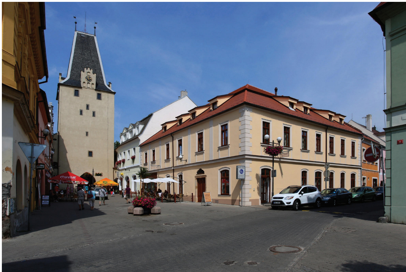
Obr. 1. Stav objektu po rekonstrukci, foto: Kateřina Neumannová, 17. 7. 2013.
