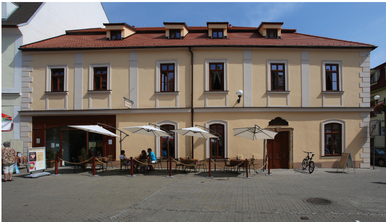
Obr. 18. Stav objektu po rekonstrukci – hlavní průčelí, foto: Kateřina Neumannová, 17. 7. 2013.
