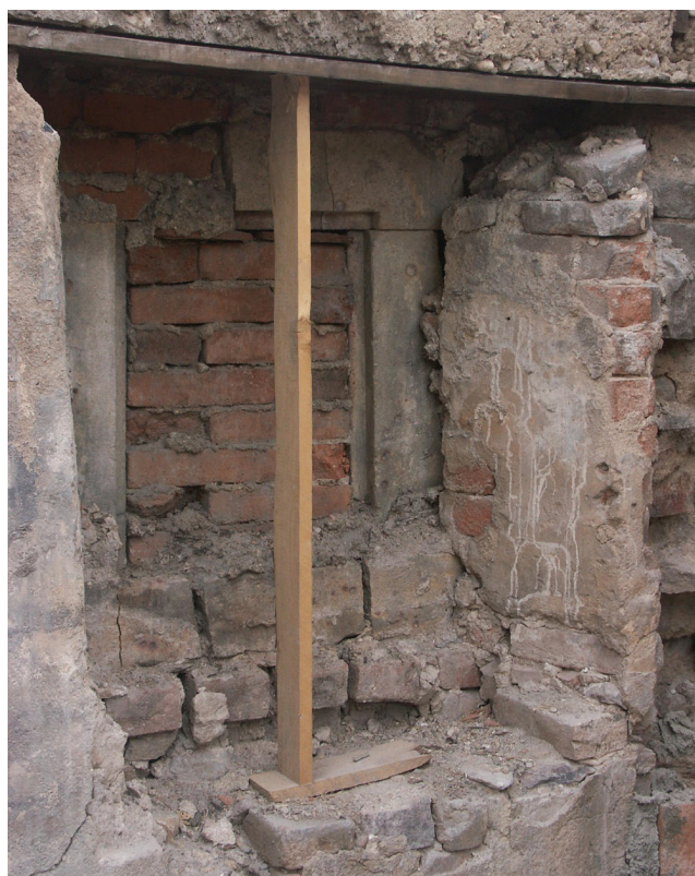
Obr. 15. Detail okenního ostění, foto: Lenka Kotišová, 5. 4. 2011.
