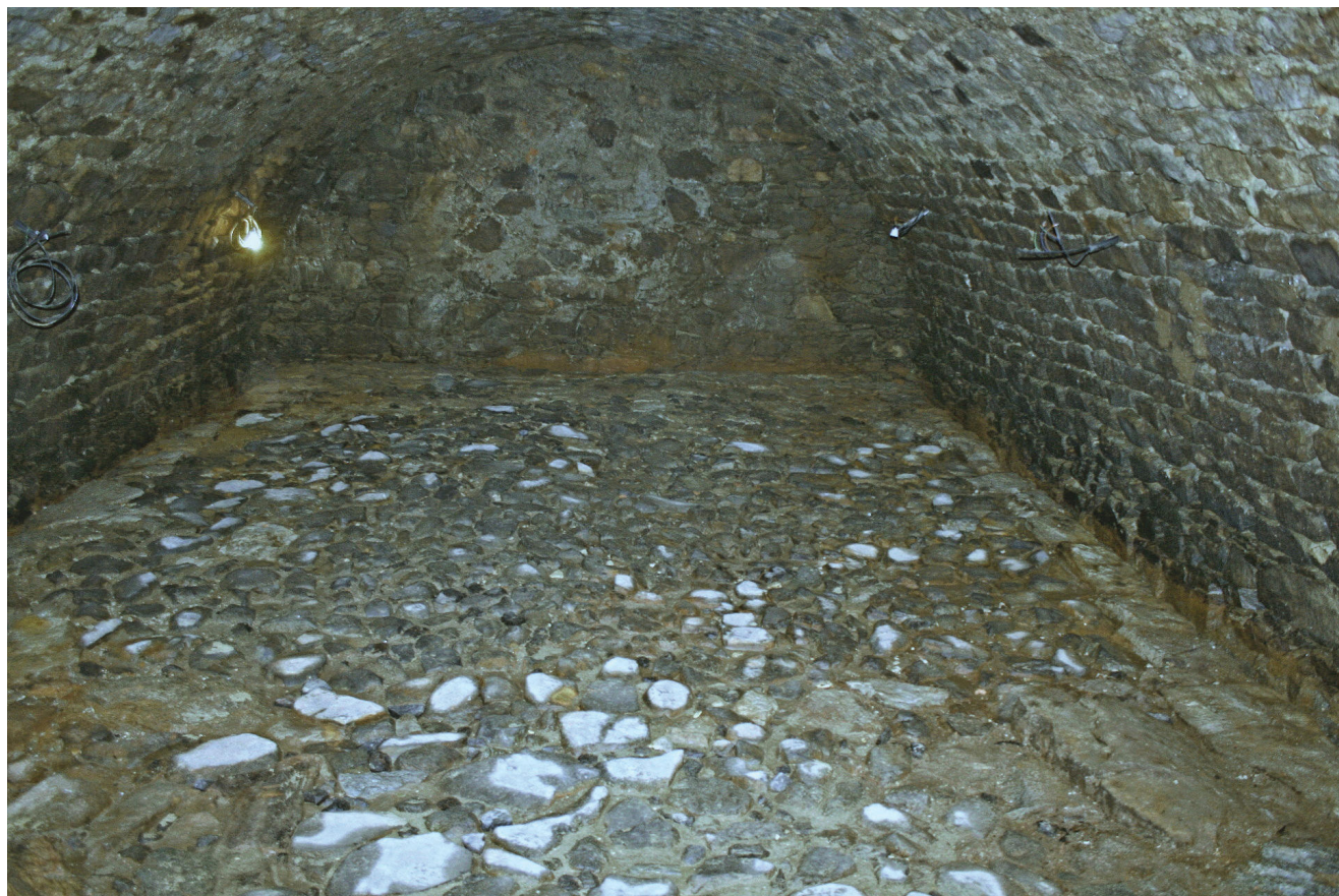
Obr. 12. Podlaha severního sklepa v pohledu k severozápadu, foto K. Podroužek.
