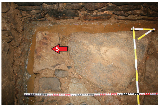
Obr. 16. Jižní roh dlažby s trasologickými stopami lícování hlavy plotny špičákem (5), foto K. Podroužek.
