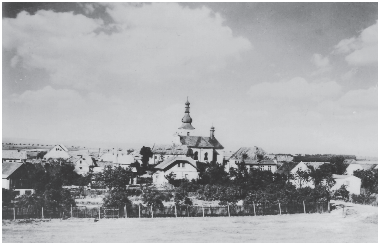
Obr. 1. Čachovice – celkový pohled, nedatováno, OM Chomutov – fond pohlednic.
