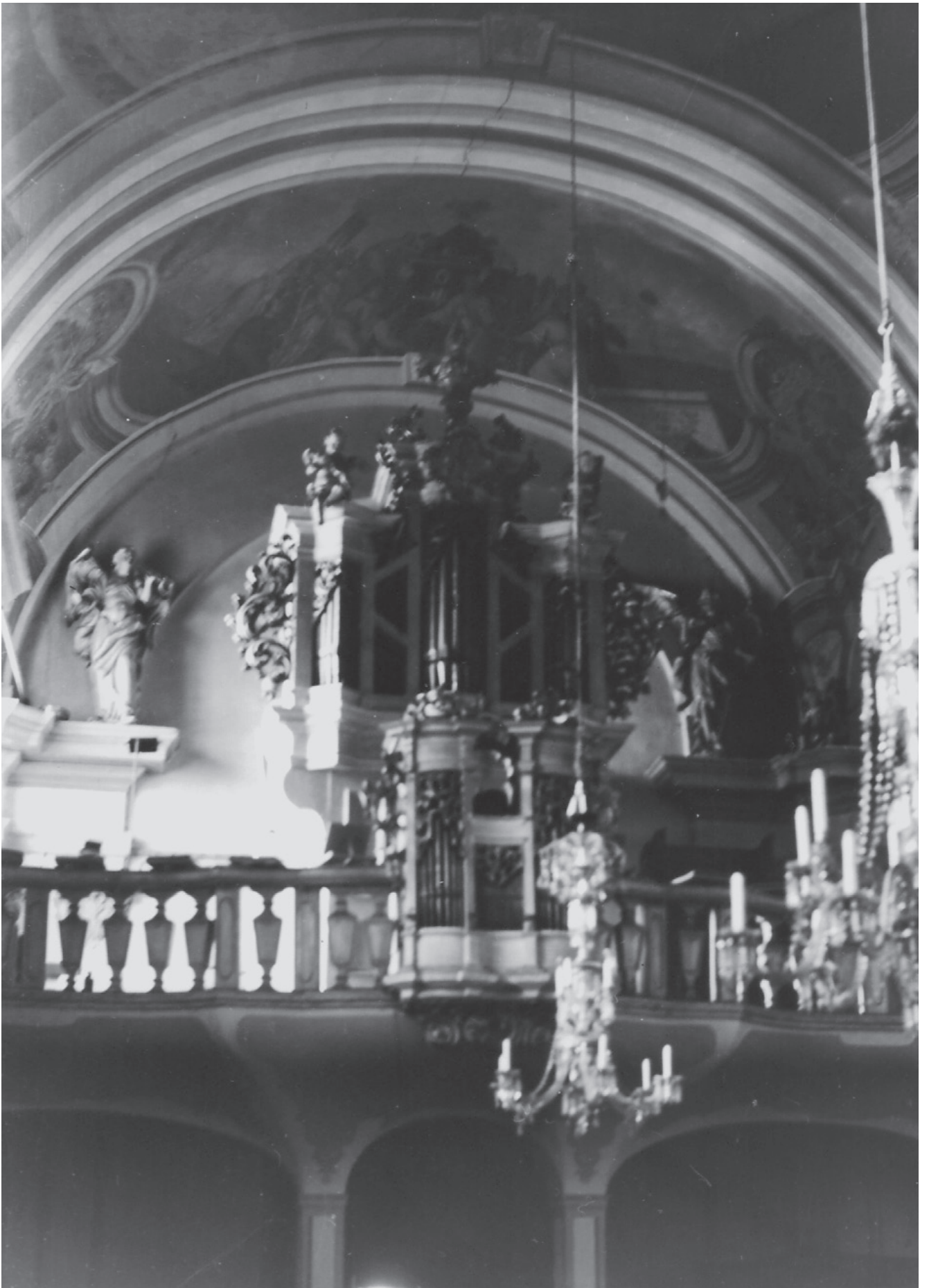
Obr. 3. Čachovice – kostel sv. Václava – pohled na emporu, 1960 – sbírka NPÚ UL, čng. 132.
