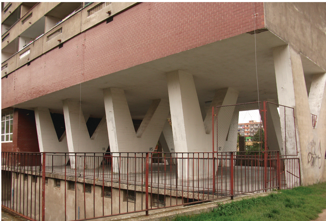
Obr. 7. Vyvýšení domu, Rudolf Berger – dům sídliště Březenecká. Foto: Lenka Hájková, 2013.
