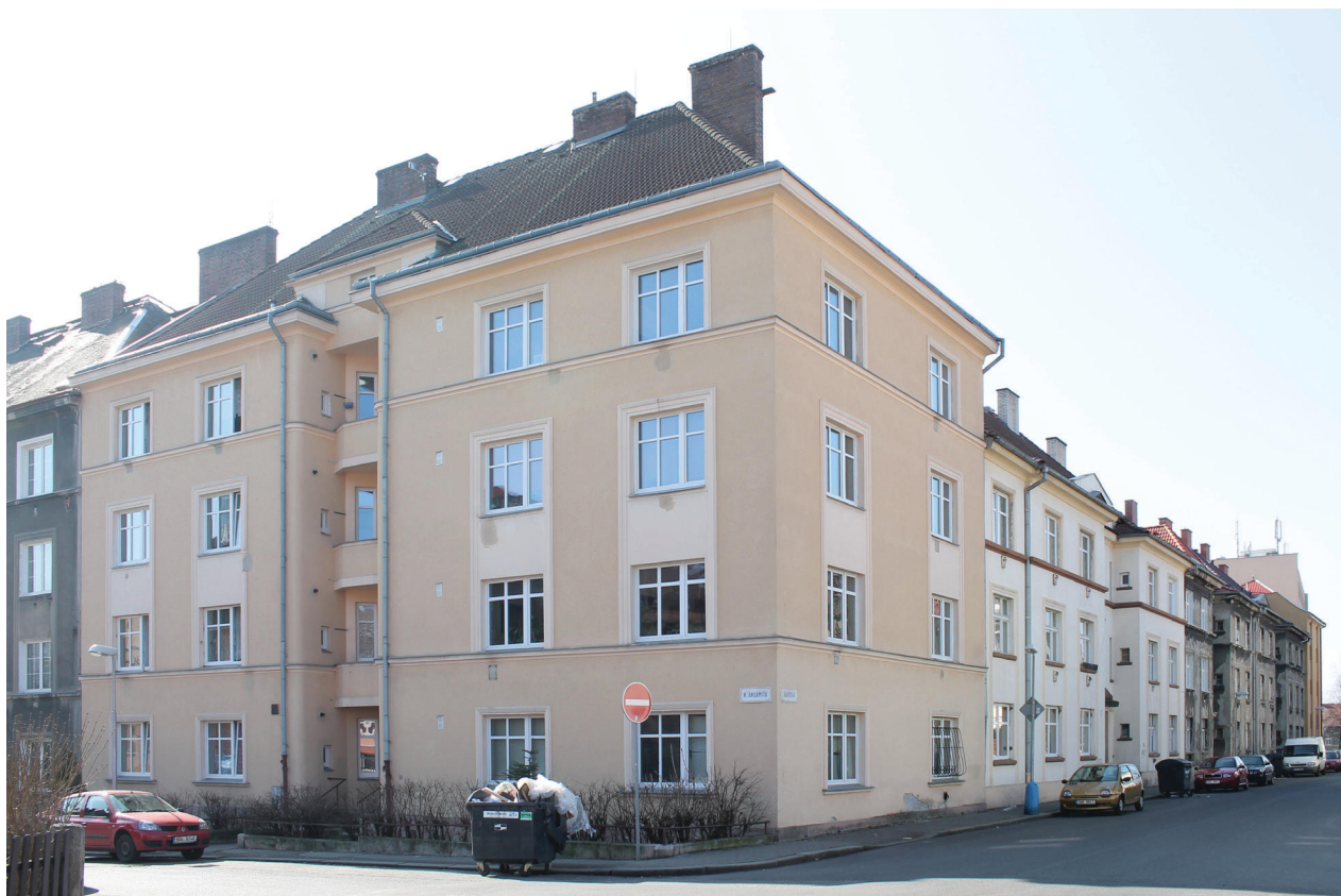
Obr. 24. Městské bytové domy. Foto: autor, 03/2014.
