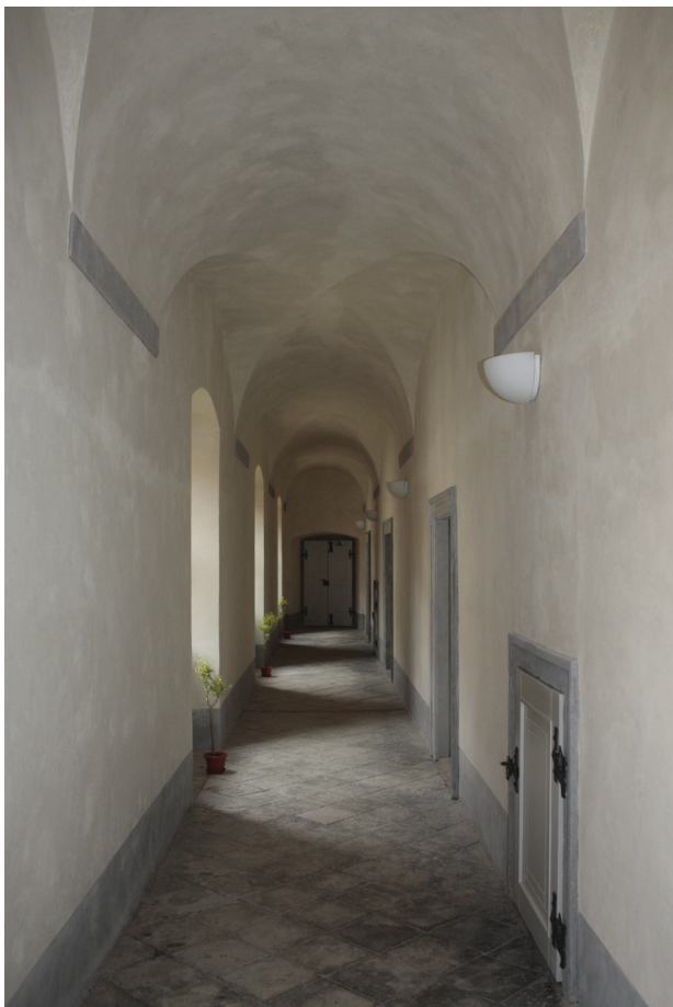
Obr. č. 2. Chodba v prvním patře spojující jižní křídlo a věž po obnově, doplněny jsou chybějící dveřní výplně, opraveny omítky a obnovena šedookrová barevnost. Foto: Lucie Radová, 2014.
