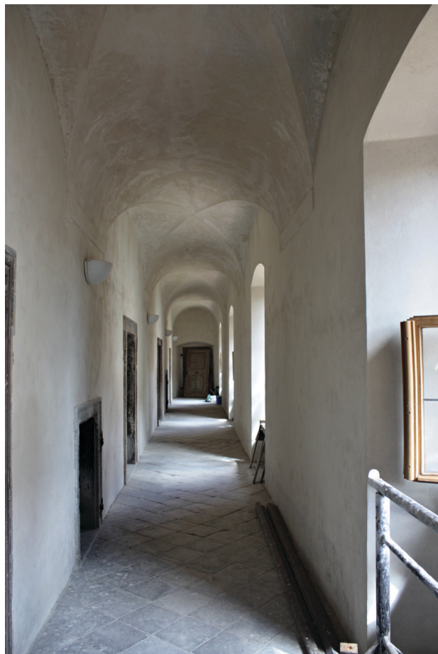
Obr. č. 1. Chodba v prvním patře spojující jižní křídlo a věž před obnovou. Foto: Lucie Radová, 2013.
