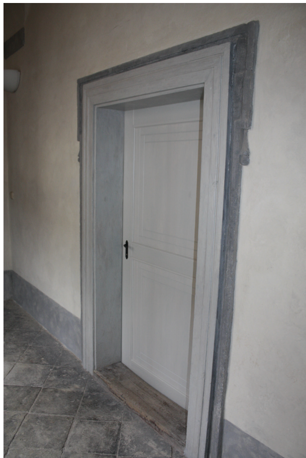
Obr. č. 3. Detail nových dveřních křídel zavěšených na původních závěsech v historických zárubních. Foto: Lucie Radová, 2014.
