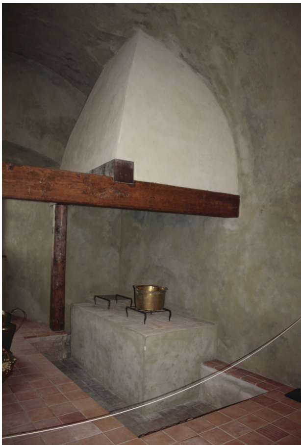
Obr. č. 6. Obnova technologického vybavení v přízemí severního křídla. Znovuvyžděný dymník v původní černé kuchyni, pod nějž bylo později vestavěno těleso chlebové pece. Foto: Lucie Radová, 2014.
