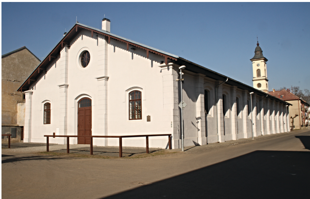
Obr. č. 2. Celkový pohled od jihovýchodu. Stav po opravě v roce 2014. Foto: Jaroslav Skopec, 2014.
