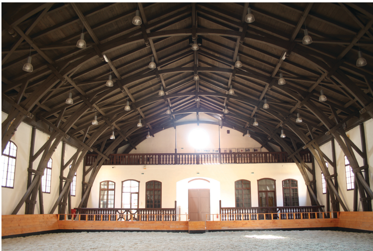
Obr. č. 4. Pohled do interiéru jízdnárny směrem k jihu. Stav po opravě v roce 2014. Foto J. Skopec 2014.
