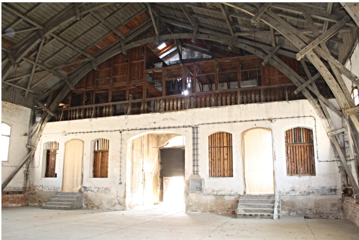
Obr. č. 3. Jižní část interiéru jízdnárny v pohledu od severozápadu. Stav před opravou v roce 2012. Foto: Jaroslav Skopec, 2012.
