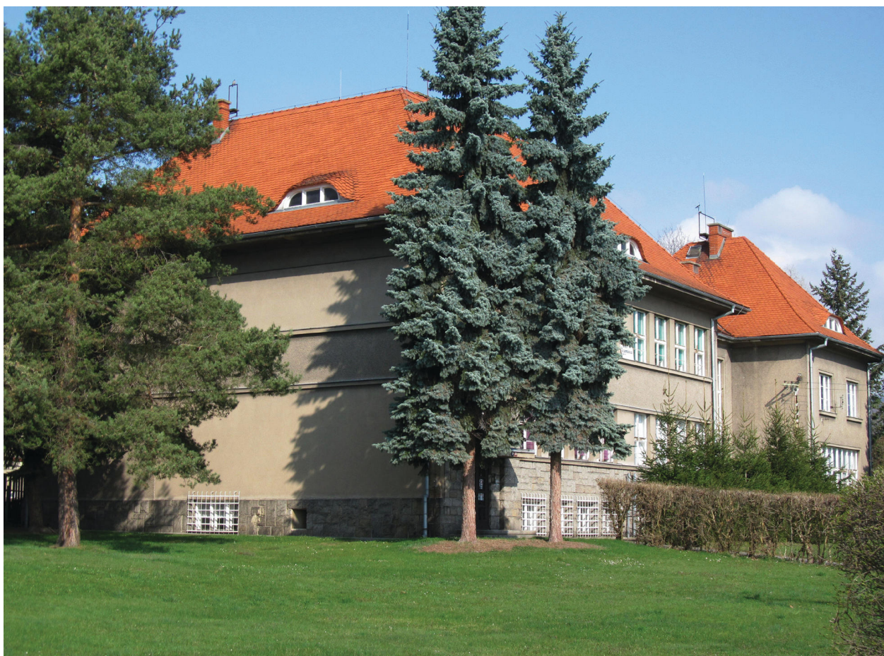
Obr. 14. Budova české obecné školy v Bystřici (dnešní součást města Dubí). Foto: Jindřich Zajíc, 26. 3. 2014.
