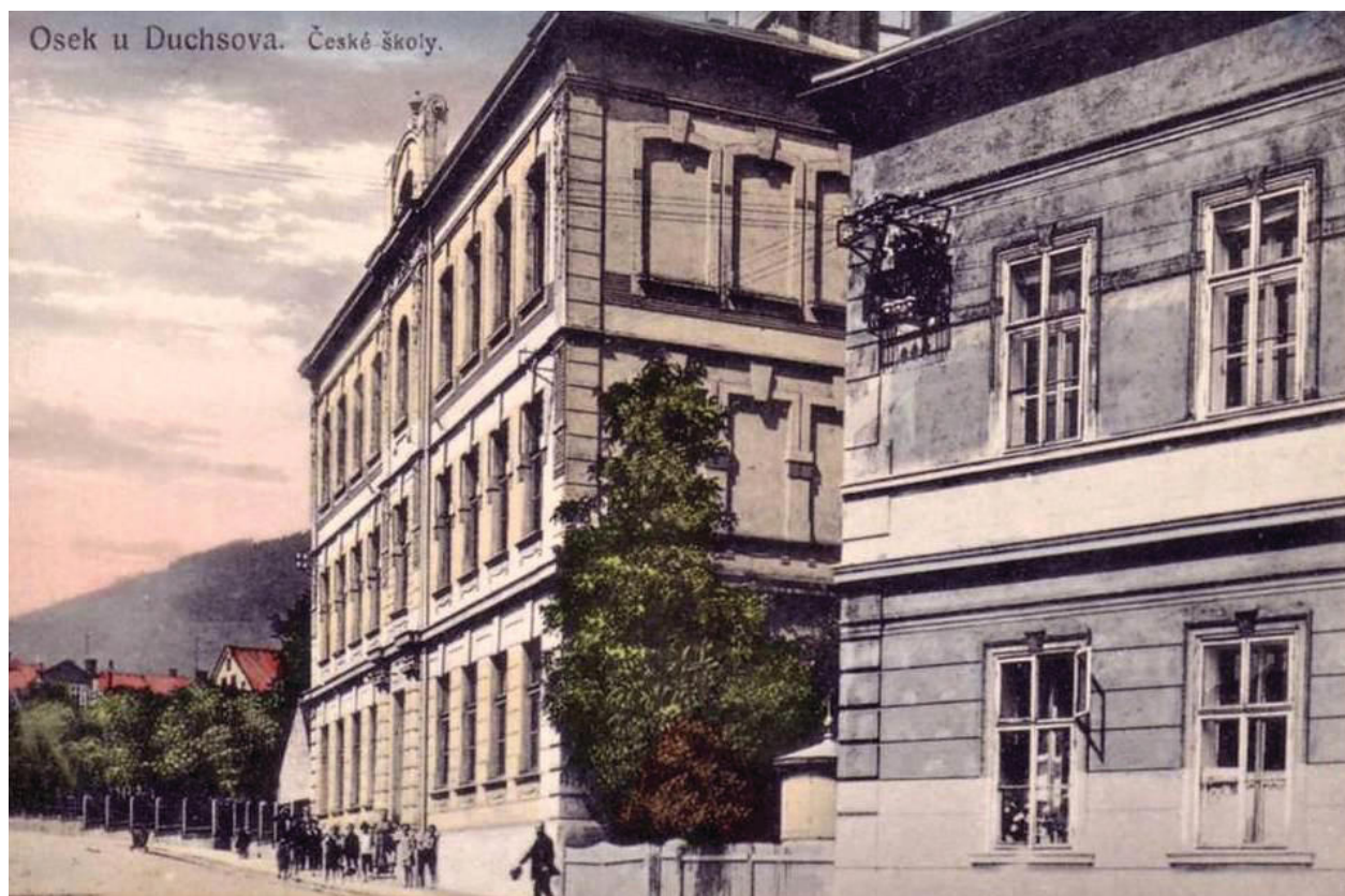
Obr. 1. Budova české obecné školy v Oseku. Stav kolem roku 1900. Sbirka autora.
