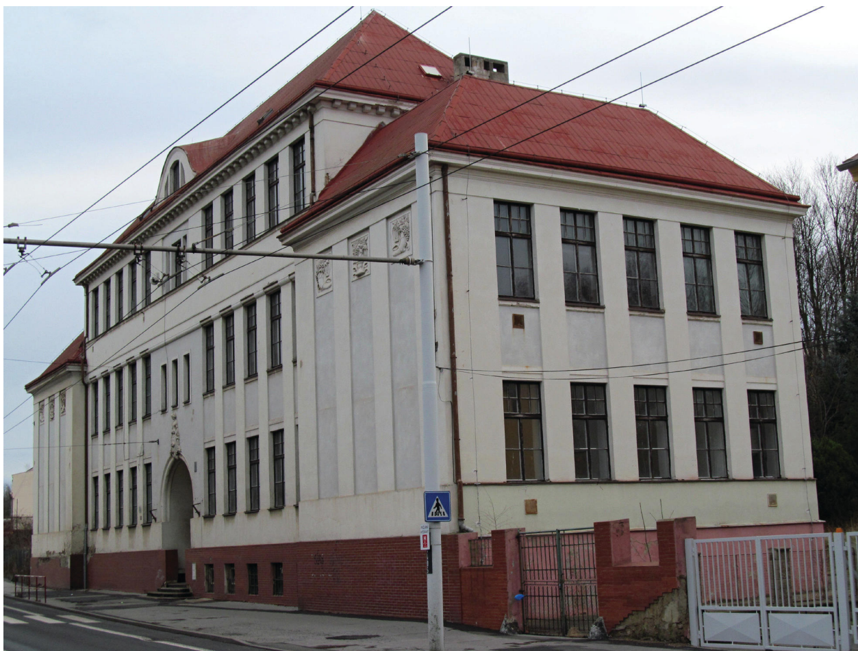
Obr. 4. Budova české obecné školy v Tepličích v dnešní Jateční ulici z roku 1912. Foto: Jindřich Zajíc, 9. 1. 2015.
