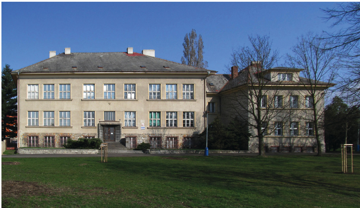
Obr. 12. Budova české měšťanské školy v Cukmantlu (dnešní Pozorka, část města Dubí). Škola byla postavena v letech 1926–1928. Foto: Jindřich Zajíc, 26. 3. 2014.
