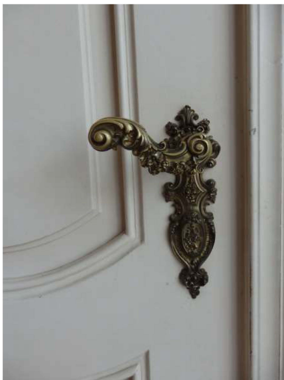
Obr. 1. Klíka u dveří do pokojů císařovny komory. V rozpočtech hlídače pokojů se obvykle vyskytuje „udržování kování oken a dveří v čistotě“. Foto: Martin Aschenbrenner, 2014.
