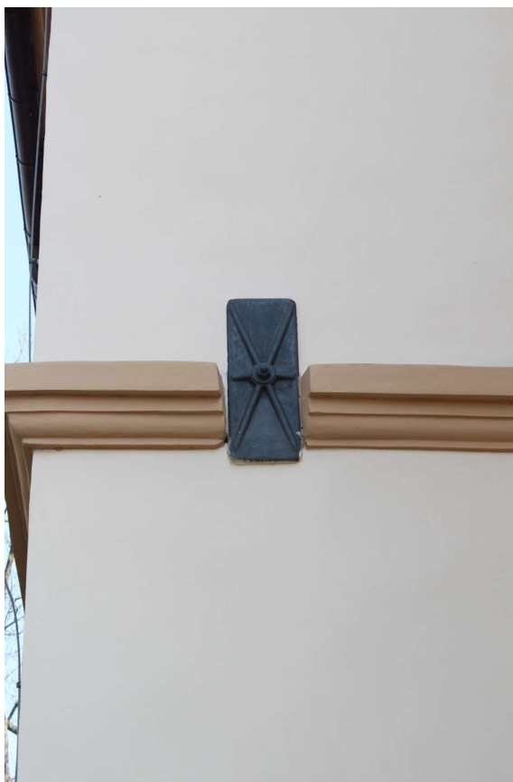
Obr. 23. Zakončení železných táhel osazených při opravě na počátku 20. století. Foto: Tomáš Brož, 2015.
