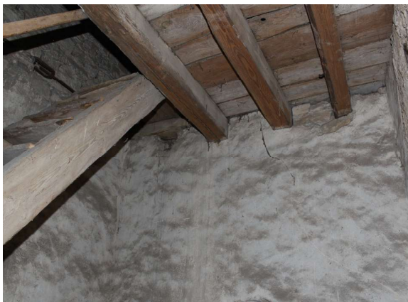
Obr. 12. Trámový trop v prvním patře věže, pohled od jihovýchodu. Foto: Tomáš Brož, 2015.
