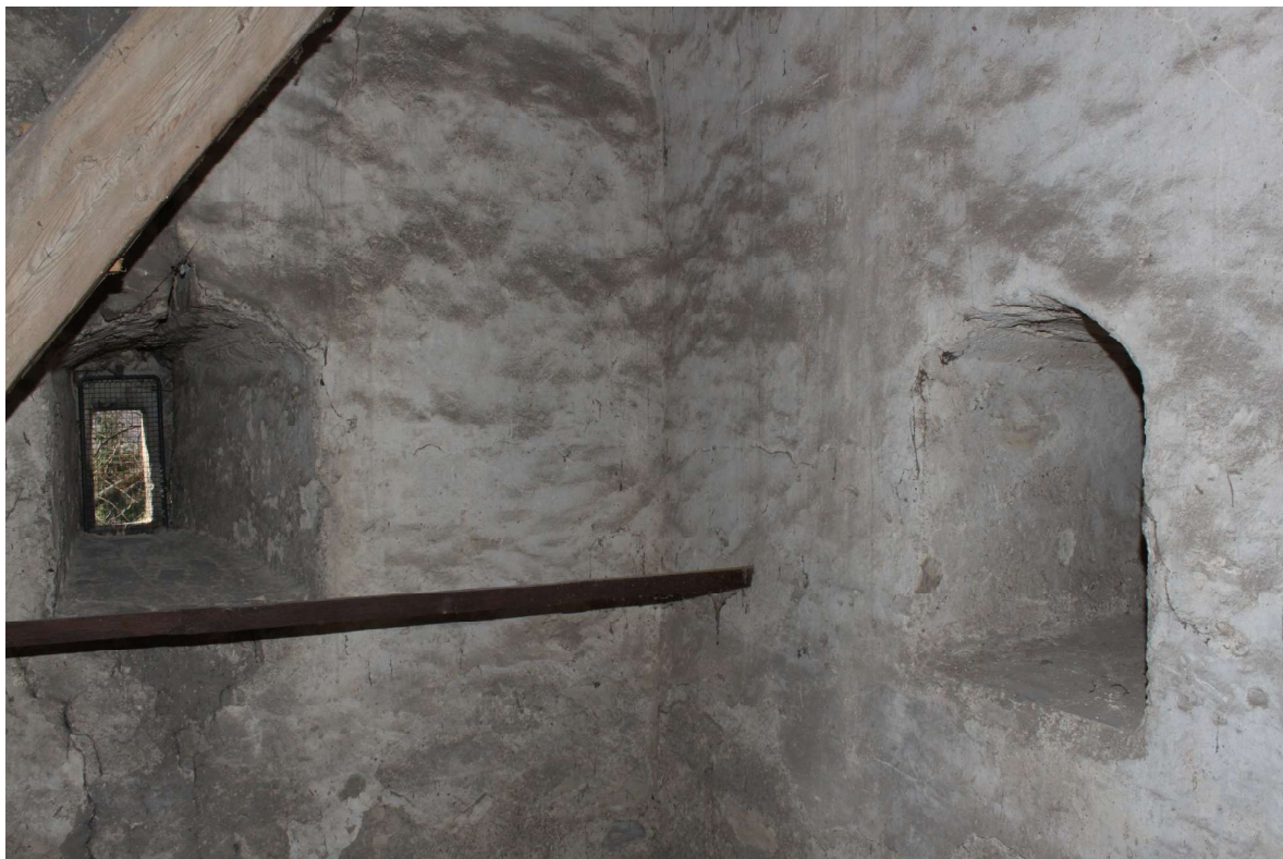
Obr. 11. První patro věže, pohled od východu. Foto: Tomáš Brož, 2015.
