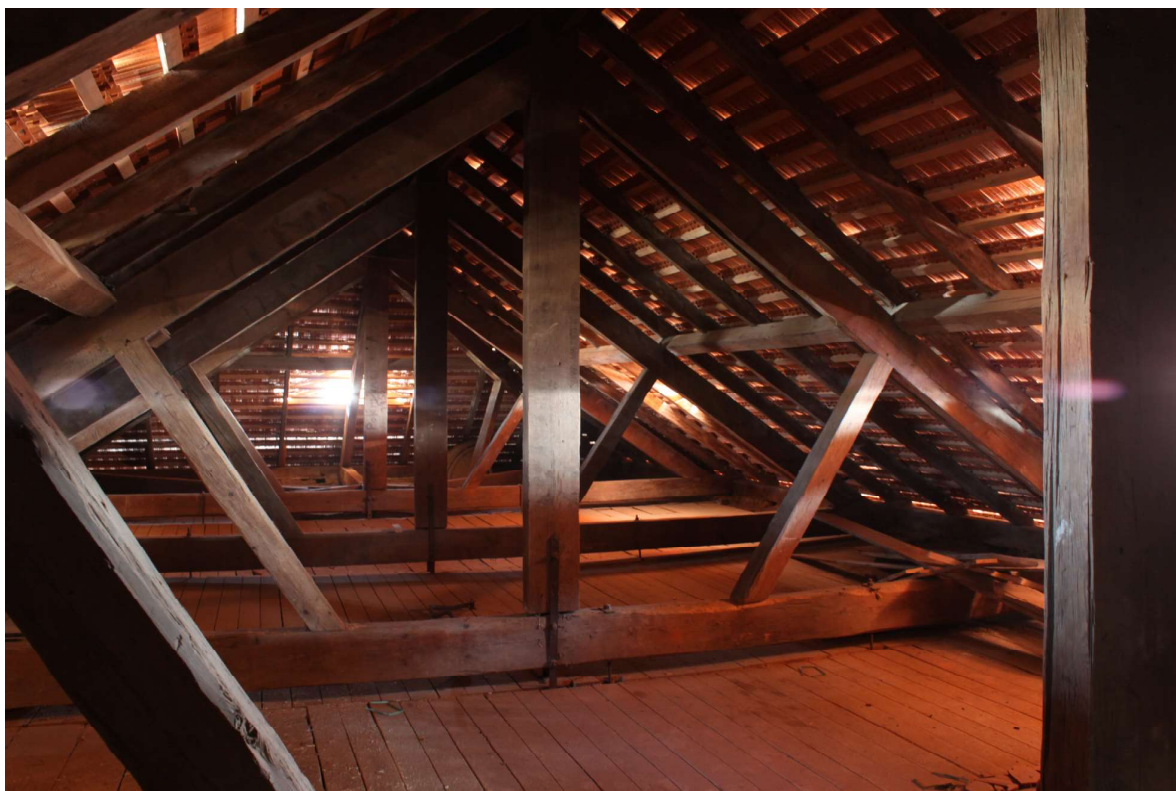
Obr. 9. Pohled od jihozápadu do krovu kostela. Foto: Tomáš Brož, 2015.
