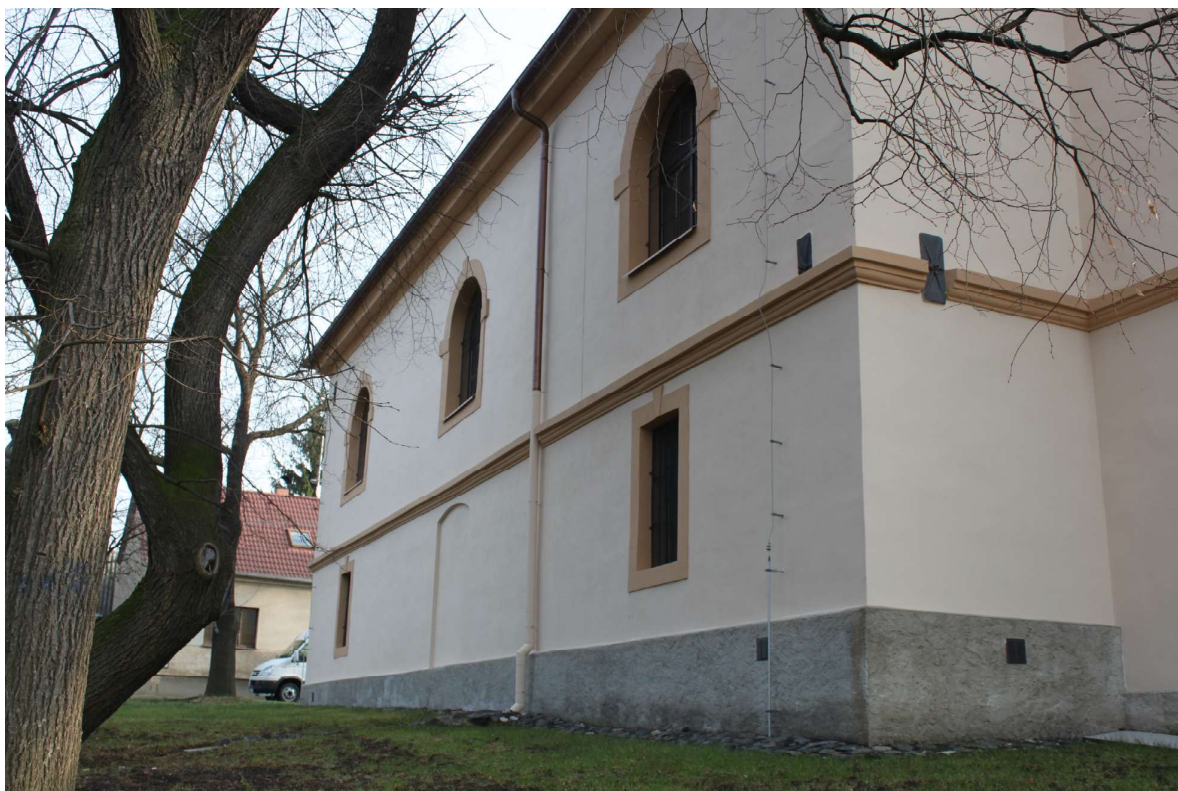
Obr. 2. Severozápadní průčelí, pohled od západu. Foto: Tomáš Brož, 2015.
