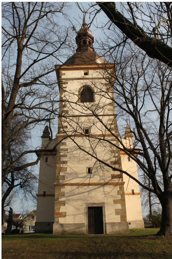
Obr. 4. Jihozápadní průčelí, pohled od jihozápadu. Foto: Tomáš Brož, 2015.
