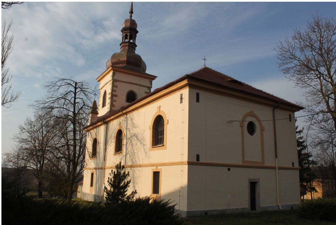
Obr. 3. Jihovýchodní a severovýchodní průčelí, pohled od severu. Foto: Tomáš Brož, 2015.
