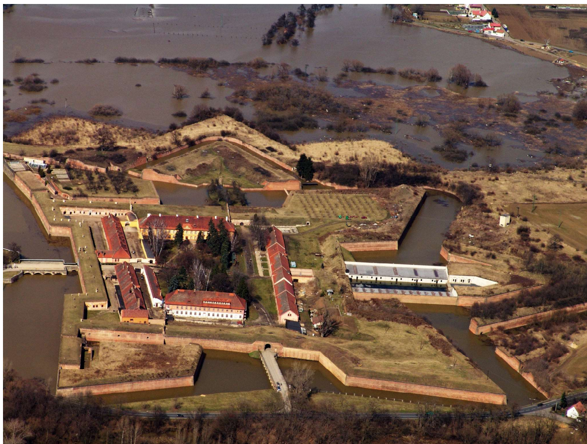
Obr. 15. Letecký pohled na fort Malá pevnost od jihu během povodní 2002. na snímku je dobře vidět zavodňovací systém pevnosti v praxi. Je patrné napuštění pevnostních příkopů a kopistské inundační kotliny. Foto: Martin Gojda, © Archeologický ústav AV ČR, v.v.i. 2012.
