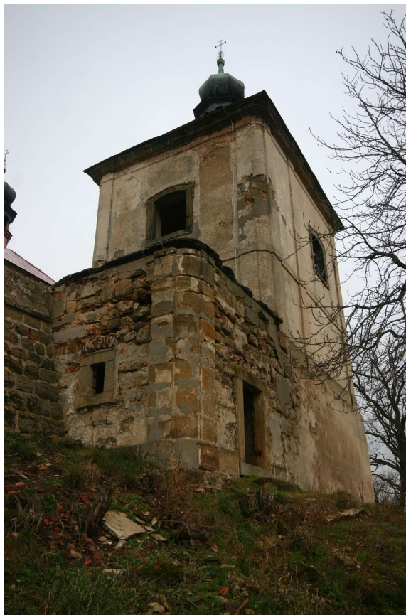
Obr. 11. Celkový pohled na kapli Nalezení sv. Kříže od jihozápadu. Foto: Miroslav Nový 2007.
