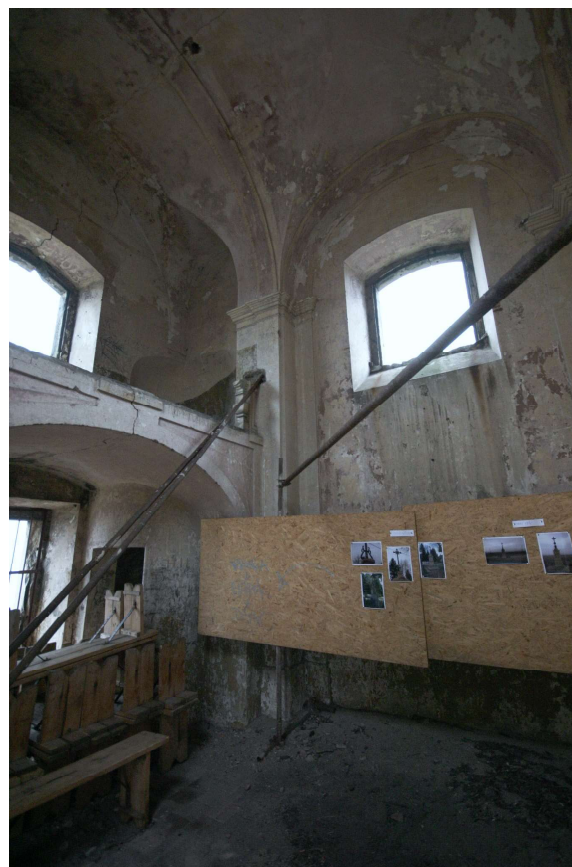
Obř. 17. Interiér kaple Povýšení sv. Kříže. Pohled k severozápadu. Foto: Miroslav Nový 2007.
