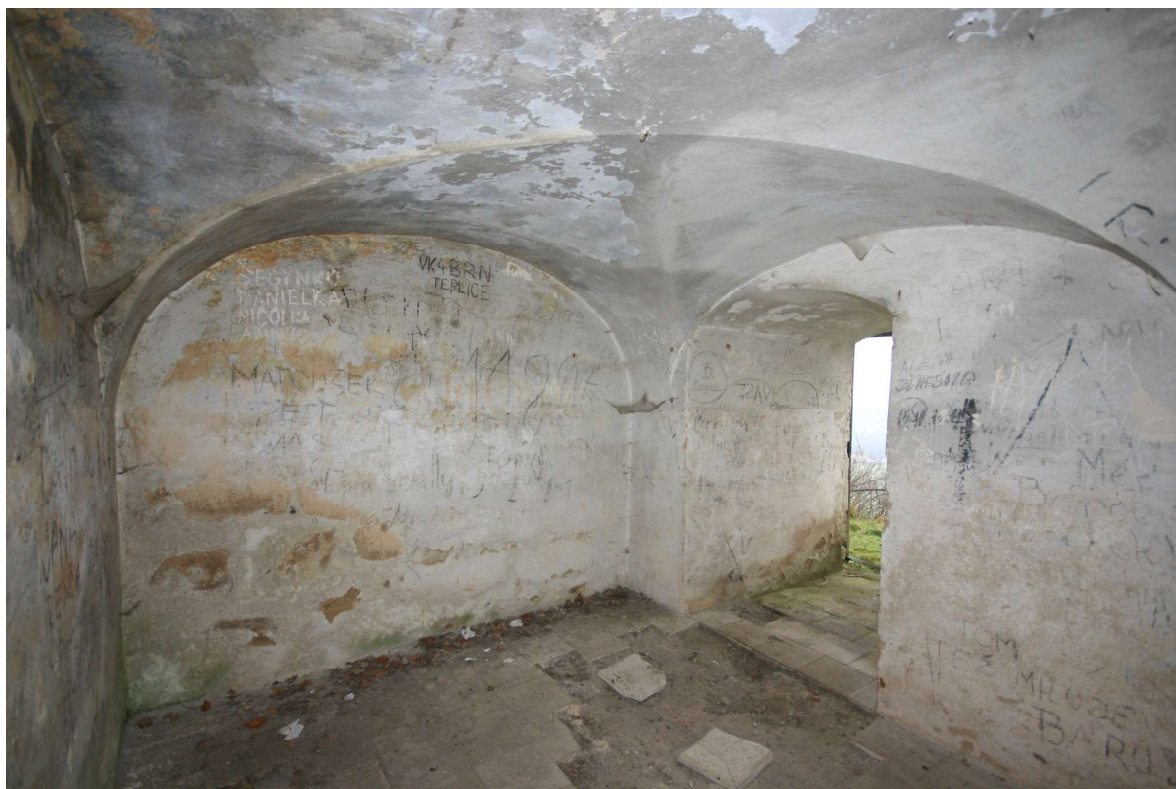
Obr. 18. Suterénní prostora pod kaplí Povýšení sv. Kříže. Pohled k severozápadu. Foto: Miroslav Nový 2007.
