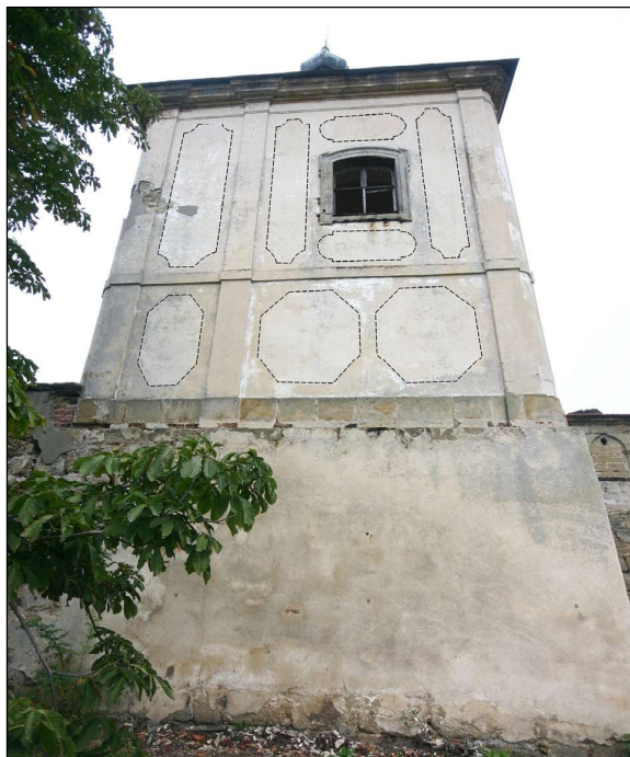
Obr. 12. Kaple Nalezení sv. Kříže. Pohled od jihu. Na snímku jsou graficky zvýrazněna geometrická pole, kterými měly být fasády původně členěny. Foto: Miroslav Nový 2007.
