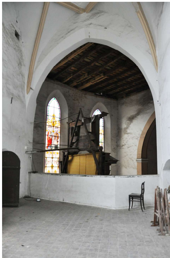
Obr. 8. Pohled do interiéru kruchty v patře staršího presbytáře ze 30. let 14. století směrem do stávajícího presbytáře kostela. Hrotitý oblouk s okosenou hranou je někdejší vítězným obloukem staršího gotického kostela. Zděná zalomená poprsnice kruchty vznikla po předělení prostoru staršího presbytáře kolem roku 1634, kdy v přízemí vznikla klenutá sakristie. Foto: Táňa Šimková 2014.
