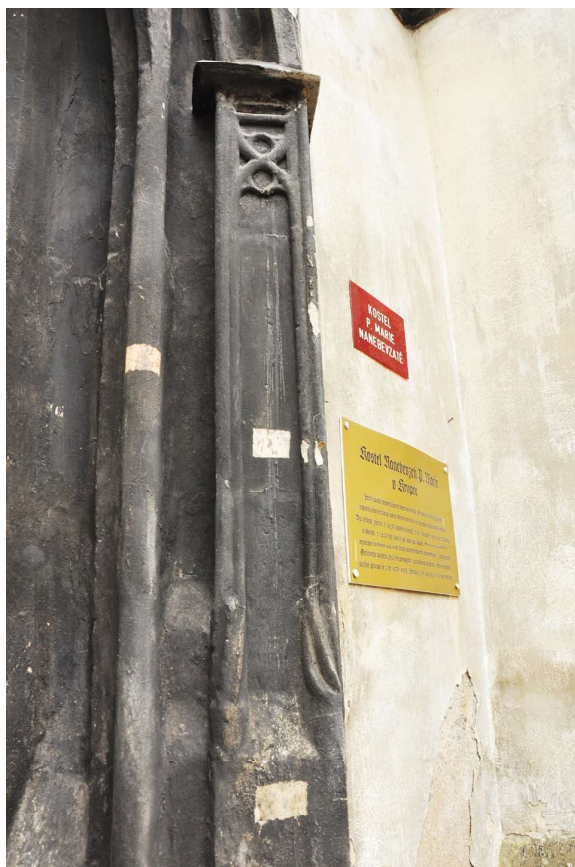
Obr. 16. Detail zpracování stojek portálu hlavního vstupu do kostela v jižním průčelí kostela. Jak dokazují nálezy v sondách na povrchu prvků, jedná se o autentické pozdně gotické části portálu z 80. let 15. století. Foto: Táňa Šimková 2014.
