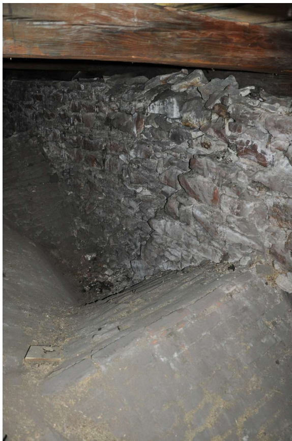
Obr. 9. Pohled na jizvy v původní klenbě staršího presbytáře kostela v obvodovém zdivu v úrovni krovu. Díky nižšímu založení stávající klenby se zachovaly jizvy výrazně převýšené hrotité klenby původního zaklenutí staršího presbytáře z doby, kdy stál na místě nynější stavby starší kostel z doby kolem poloviny 14. století. Foto: Táňa Šimková 2014.
