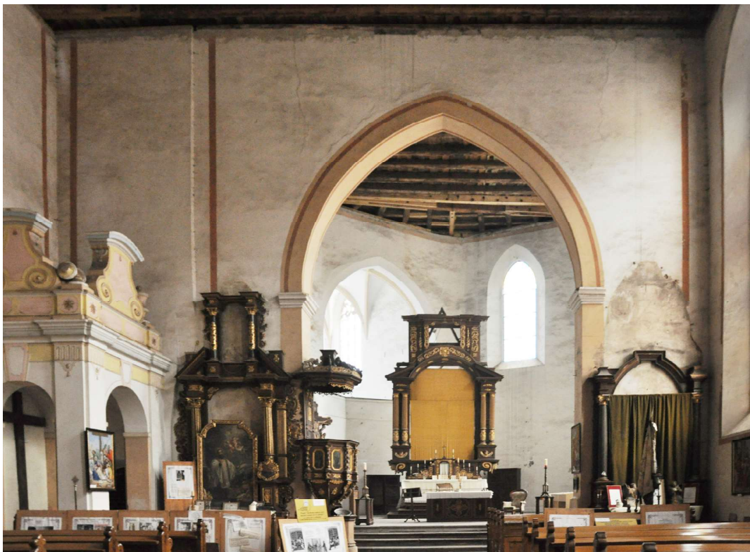
Obr. 2. Pohled do interiéru kostela od západu směrem do mladšího presbytáře z konce 15. století. Při levém koutě přechodu presbytáře k lodi je patrný výběh zdiva, značící původní šířku pozdně gotické lodi před rozšířením při raně barokní přestavbě kolem roku 1634. Lomený vítězný oblouk nese podobu po úpravě v letech 1668–1672, kdy byl podezděn a opatřen výraznými štukovými hlavicemi stojek. Foto: Táňa Šimková 2014.
