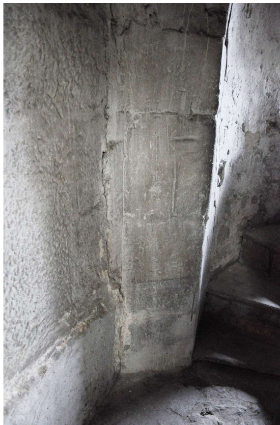
Obr. 14. Detail reliktu stojky staršího vstupu na schodiště ve věži v koutě staršího presbytáře kostela. Otvor byl zarděn zřejmě v první polovině 17. století po vzniku sakristie v přízemí staršího presbytáře, kdy se na schodiště vstupovalo nově proraženým vstupem z nynějšího presbytáře kostela. Foto: Táňa Šimková 2014.
