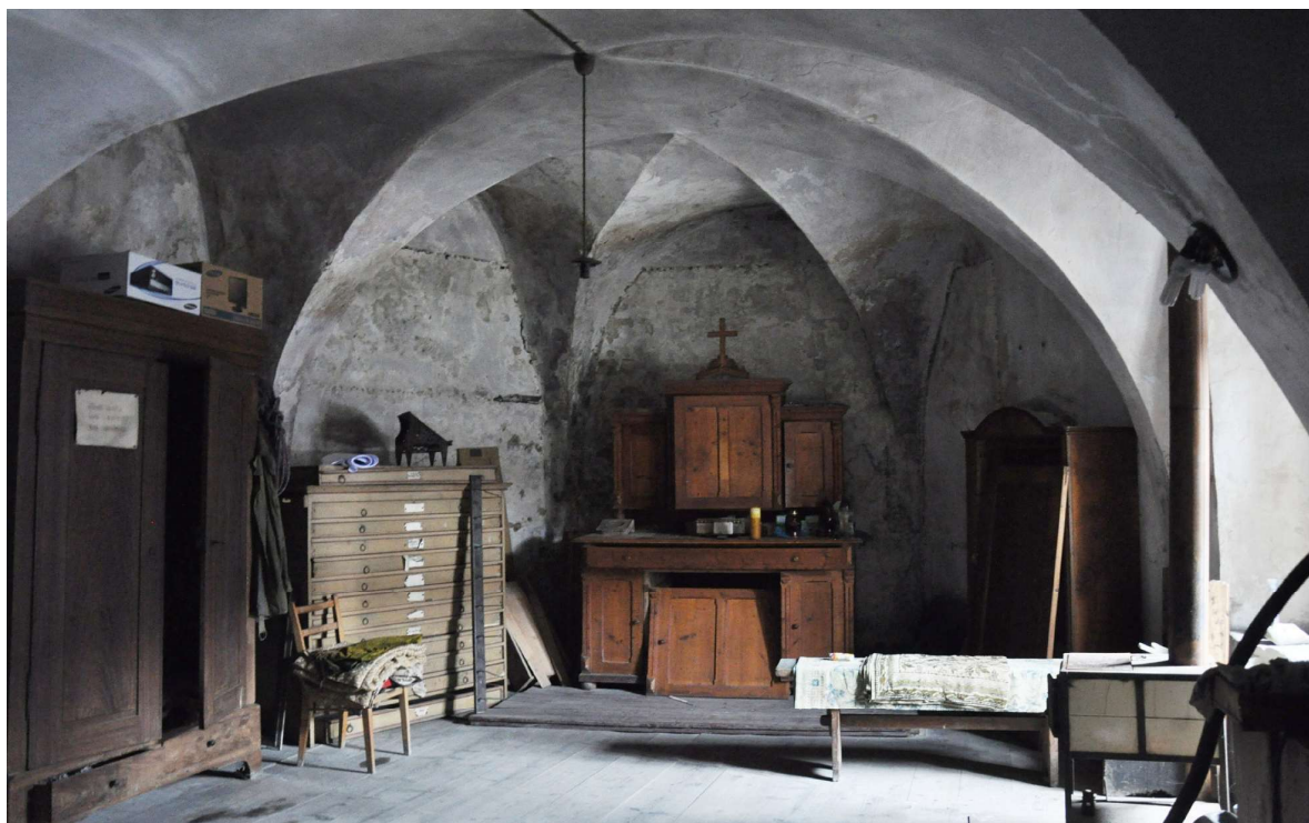
Obr. 6. Pohled do interiéru sakristie v přízemí staršího presbytáře kostela z 1. poloviny 14. století od východu. Sakristie pravděpodobně vznikla rozdělením staršího prostoru ze 14. století výrazně mladší raně barokní klenbou z 30. let 17. století. Vybudování sakristie s nejvyšší pravděpodobností souviselo s rekatolizačními procesy v Krupce, jež se odrazily do dispozičního řešení kostela. Foto: Táňa Šimková 2014.
