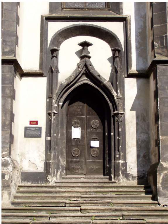
Obr. 15. Detail regotizovaného portálu hlavního vstupu do kostela v jižním průčelí kostela. I přes to, že podoba portálu byla výrazně upravena na poč. 20. století, je převážná část jednotlivých prvků původní a lze tak s velkou přesností rekonstruovat jeho pozdně gotickou podobu před druhotnými zásahy. Foto: Táňa Šimková 2013.
