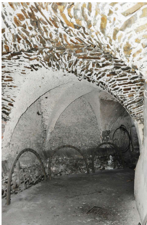
Obr. 5. Pohled do interiéru spojovací chodby pod presbytářem kostela od severu. V soklu chodby byly pravděpodobně druhotně užity kamenné sekané bloky ze starší stavby kostela z 1. poloviny 14. století. Foto: Táňa Šimková 2014.
