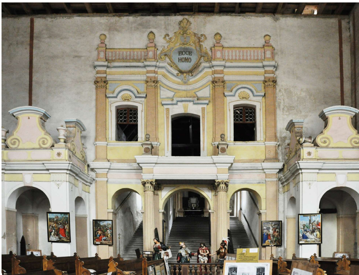
Obr. 4. Pohled na kulisové průčelí Svatých schodů při severní zdi lodi. Svaté schody vznikly jako nejmladší část kostela proražením východní zdi kostelní lodi a vestavbou vlastní stavby Svatých schodů mezi lety 1735–1739. Pojednání monumentálního průčelí autenticky odráží způsob barokního náboženského působení 18. století na věřící. Výstavba Schodů v Krupce zřejmě reagovala na zbudování poutního chrámu Bolestné Matky Boží v Bohosudově na počátku 18. století. Foto: Táňa Šimková 2014.
