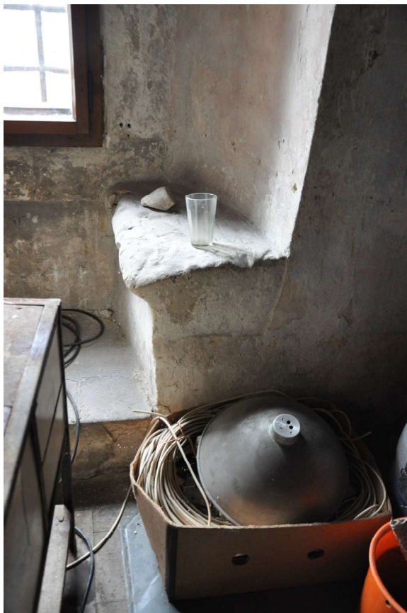
Obr. 13. Detail kamenného sedátka v reliktu okenního otvoru v sakristii v přízemí staršího presbytáře kostela. Zachovaná situace potvrzuje druhotné předělení staršího presbytáře v 30. letech 17. století vyzděním klenby sakristie. Foto: Táňa Šimková 2014.
