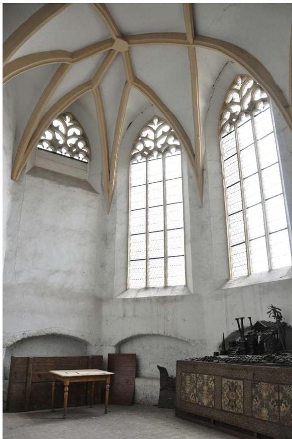
Obr. 7. Pohled do interiéru kruchty v patře staršího presbytáře kostela ze 30. let 14. století od východu. Stávající klenba je mladší než vlastní prostor, datačně ji lze spojit s výstavbou nového kostela v 80. letech 15. století, která do sebe pojala relikv stávajícího kostela. Ze stejného období pochází rovněž úprava okenních otvorů, jejichž kružby se svou podobou hlásí do pozdní gotiky závěru 15. století. Foto: Táňa Šimková 2014.
