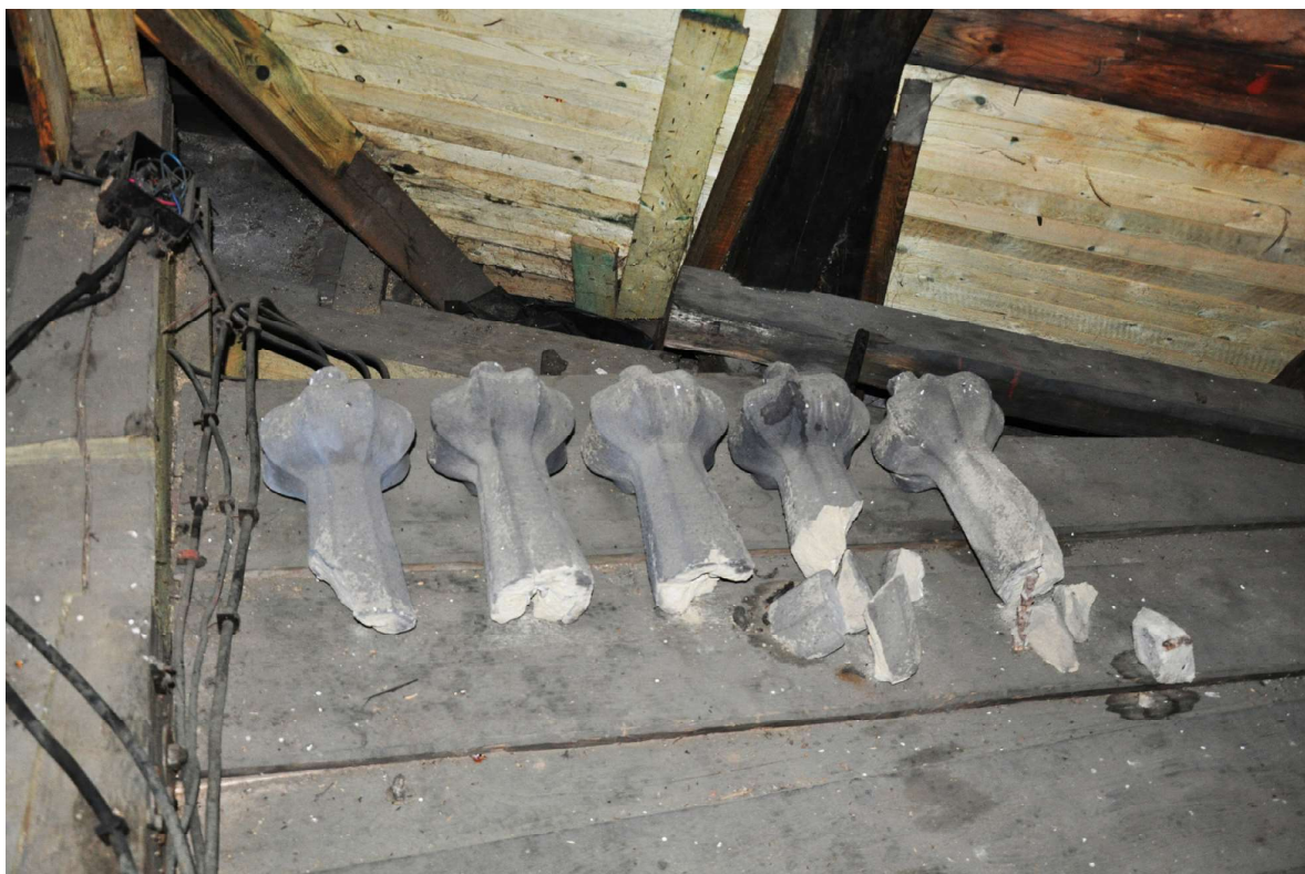
Obr. 21. Detail v krovu druhotně deponovaných kamenných čučků z vrcholů opěráků lodi. Čučky pocházejí z puristické regotizační úpravy kostela na počátku 20. století. Foto: Táňa Šimková 2014.
