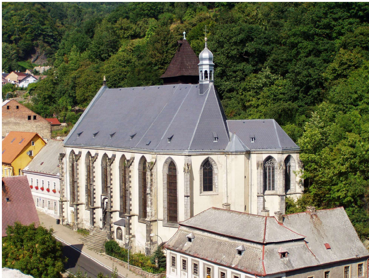
Obr. 1. Celkový pohled na kostel Nanebevzetí Panny Marie v Krupce od jihovýchodu. Řešení fasády vychází z poslední výrazné opravy kostela v puristickém stylu v letech 1909–1935. Foto: Táňa Šimková 2014.
