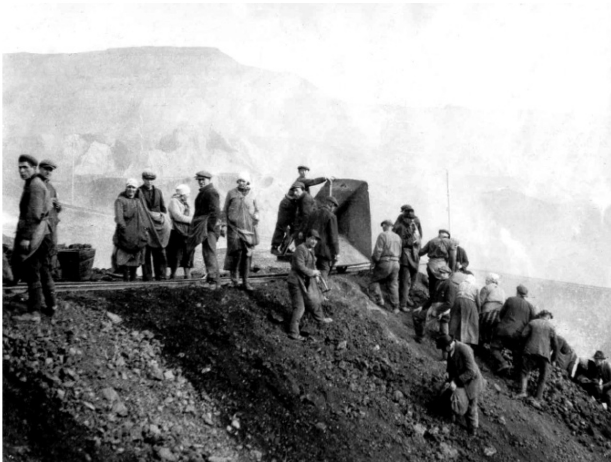
Obr. 9. Na haldě, Duchcovsko, 20. léta 20. století, Muzeum města Duchcova, fond Hornictví – sbírka fotografií.
