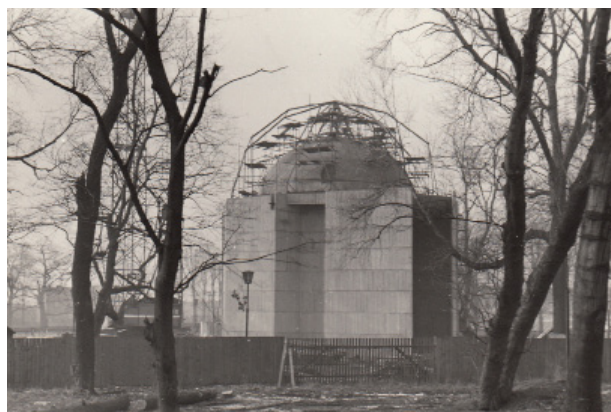
Obr. 9. Konstrukce pro plechovou střešní krytinu nad kupolí pavilonu pro Reinerovu fresku, léta 1975–1976, fotografie; MMD, Barokní památky v Duchcově (Zbouraný špitál a kaple sv. Barbory), S-XXXII, nečíslováno.
