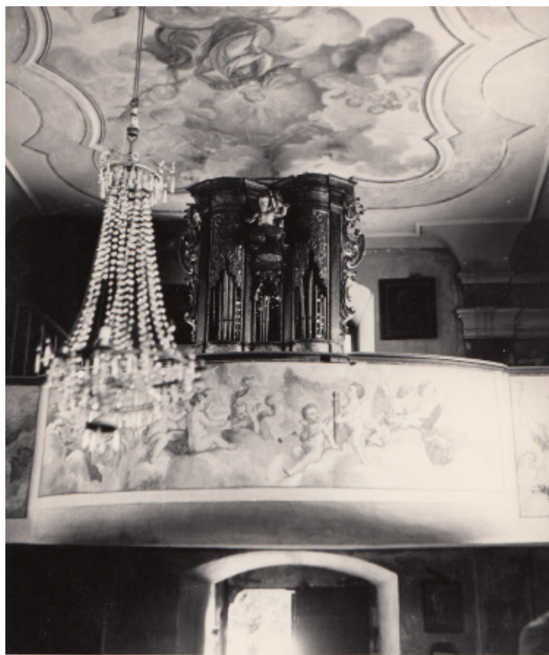
Obr. 3. Stránc, okr. Most, zámek, kaple, interiér, pohled ke kůru s ještě relativně zachovalým prospektem rokokového varhanního pozitivu (torzo dnes deponováno na SZ Jezeří). Část vybavení byla přenesena do kaple v Žiželicích u Žatce, kde bylo odcizeno po roce 1990. Foto: NPÚ ÚOP Ústí nad Labem, neznámý autor, 1961.
