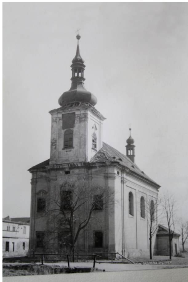
Obr. 4. Slatinice, okr. Most, kostel sv. Šimona a Judy krátce před zbořením. Vyjádření k upuštění od památkové ochrany konstatovalo, že se jedná o poměrně hodnotnou barokní architekturu, nachází se však v hnědouhelné oblasti, kde bylo o upuštění od památkové ochrany už dříve globálně rozhodnuto. Foto: NPÚ ÚOP v Ústí nad Labem, Alois Machata, 1969.
