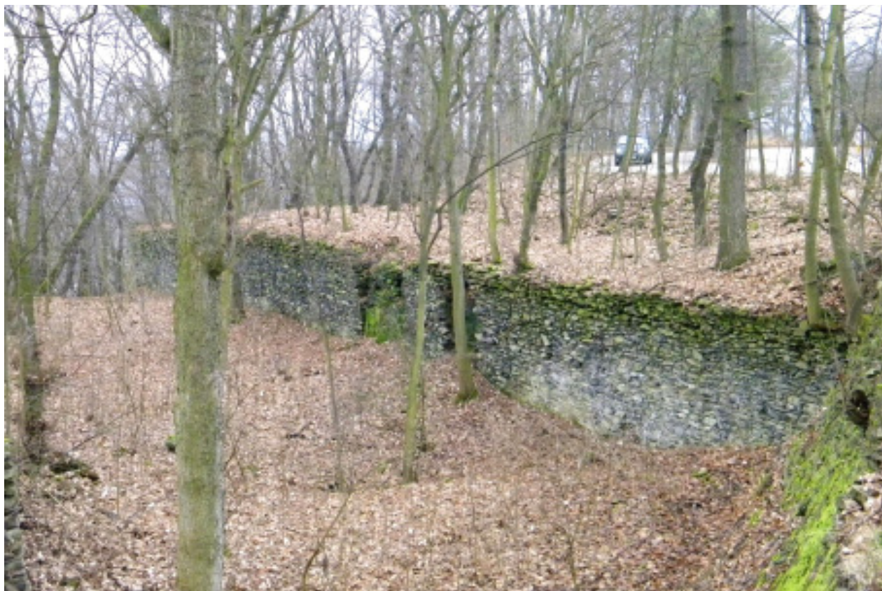
Obr. 4. Ravelin před vstupní bránou. Výška zdiva průměrně 3 metry. Foto: Lukáš Sláma, 2014.
