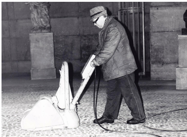
Obr. 7. Josef Záda při čištění podlahy v pavilonu pro Reinerovu fresku v roce 1983; MMD, Josef Zada, S-XXIX, nečíslováno.
