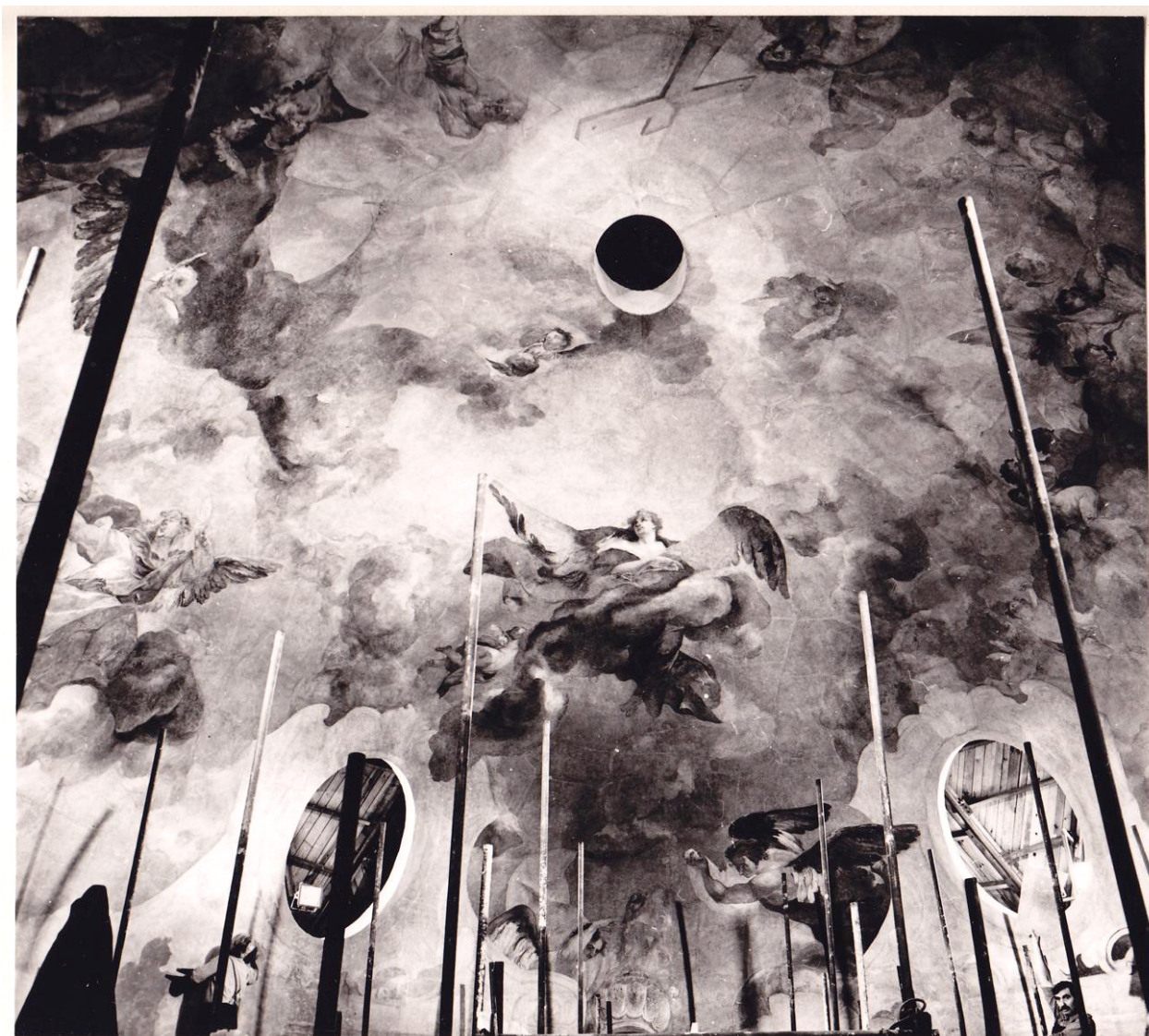
Obr. 4. Reinerova freska v pavilonu, stav po osazení a restaurování – detail s lešením, in: Zpráva o osazení a restaurování fresek V. V. Reinerova v novém pavilonu v Duchcově, datováno v Praze 17. 7. 1982; NPÚ ÚOP v Ústí nad Labem, odborná spisovna, restaurátorská zpráva, č. 494/R, sine pag.
