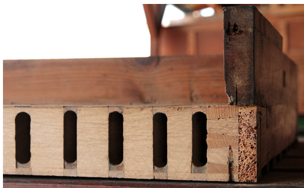
Obr. 6. Klášterec nad Ohří, kostel Nejsvětější Trojice, zadní část vzdušnice hlavního stroje po odstranění dodatečného přístavku s proříznutými kancelami. Foto: Jaromír Kánský, 2017.
