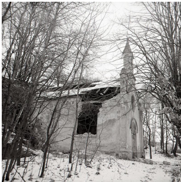
Obr. 9. Mírkov, kaple Navštívení Panny Marie, západní pohled na pokročilou destrukci objektu, 70. léta 20. století. Foto: Sbirka fotodokumentace NPÚ ÚOP v Ústí nad Labem.
