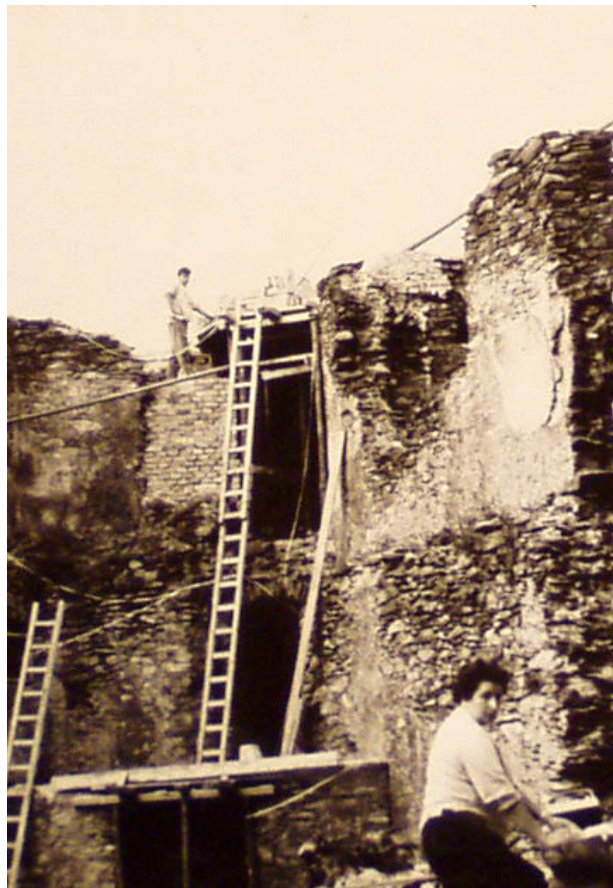
11) Hrad Doubravka, stavební obnova, 1969. Foto: AVZO TSC ČR Teplice hrad Doubravka, p. s.
