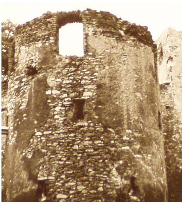
9) Hrad Doubravka, stav objektu před záchranou, obnovou a dostavbou, 1966.
