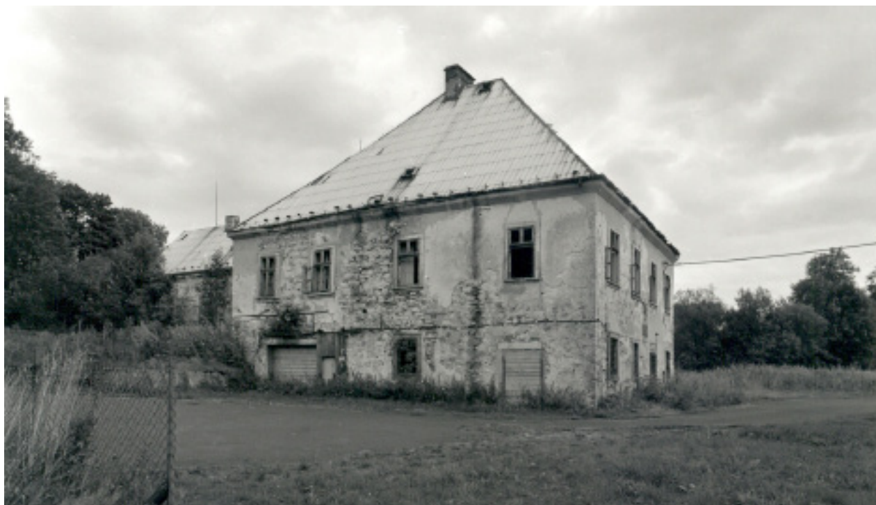
6) Krásný Les, pohled na zámek od severozápadu, 2010. Foto: Radomír Báča, NPÚ ÚOP v Ústí nad Labem.
