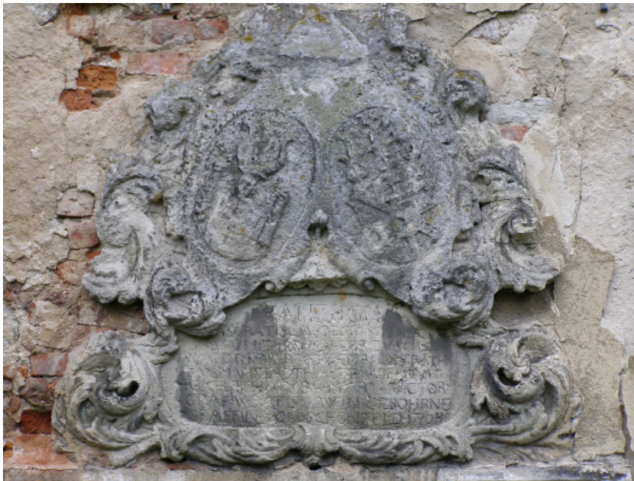
5) Stejná deska jako na předchozím snímku, stav v roce 2008. Foto: Jan Koloc, NPÚ ÚOP v Ústí nad Labem.
