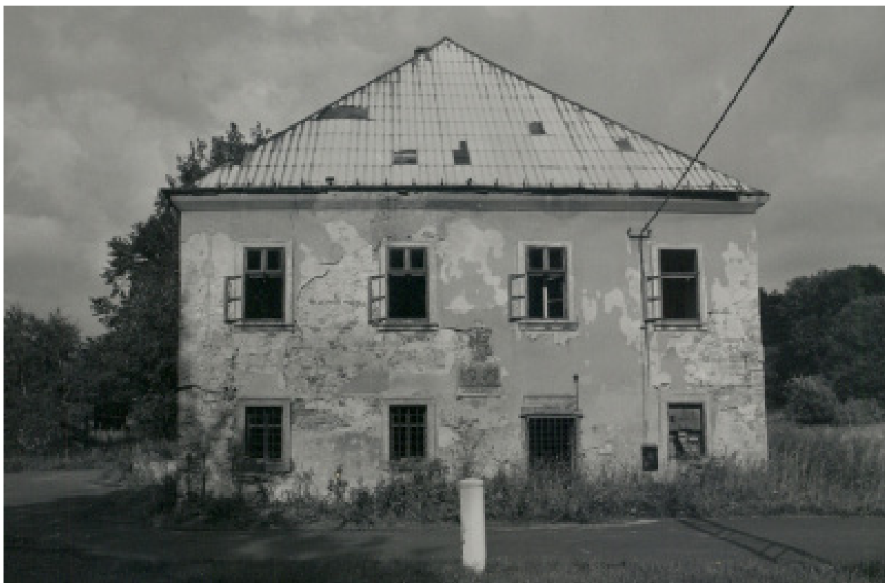
9) Krásný Les, pohled na zámek od západu, 2010. Foto: Radomír Báča, NPÚ ÚOP v Ústí nad Labem.
