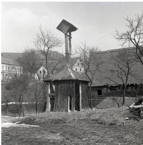
26) Mašovice, dobový snímek zvonice dokumentující její postupnou destrukci. V pozadí je vpravo zachycena fasáda hostince Zur Alpenhöhe. Ze zobrazených budov stojí dnes pouze objekt, jehož štít se třemi řadami oken vykukuje vpravo za zvonici. Zdroj: Muzeum města Ústí nad Labem, asi rok 1958.
