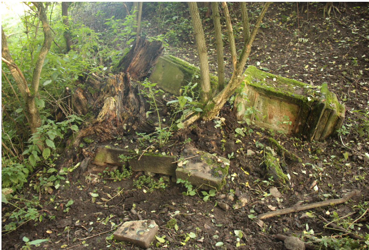
33) Mašovice, na kříži IV. se „vandalství“ dopustila příroda. Kříž byl vyvrácen kořeny dnes již mrtvého stromu. Pohled od jihu. Foto: NPÚ ÚOP v Ústí nad Labem, Martin Zubík, 2021.
