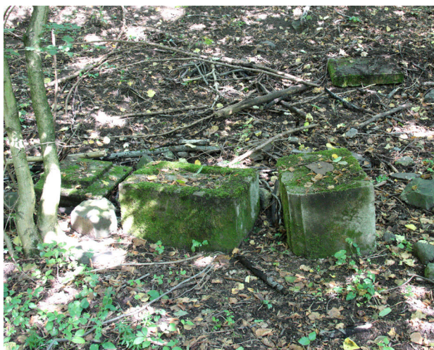
8) Lužec, pohled od jihu na čtyři povalené součásti betonové podstavcové architektury kříže na polní (lesní) cestě za čp. 244. Na mohutné patce vpravo leží zkorodovaná litinová část nápisového terče z nedochovaného kříže. Foto: NPÚ ÚOP v Ústí nad Labem, Martin Zubík, 2021.
