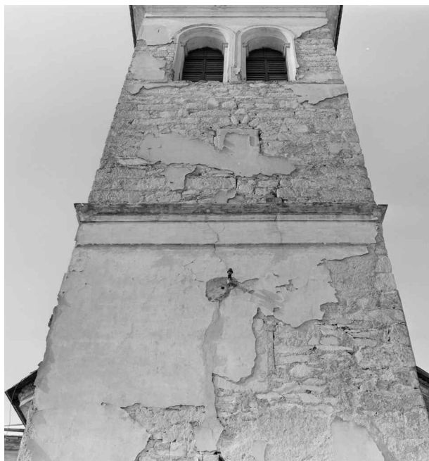
12) Východní průčelí věže před opravou omítek, pohled od východu. Foto: Roman Kurša 1993.
