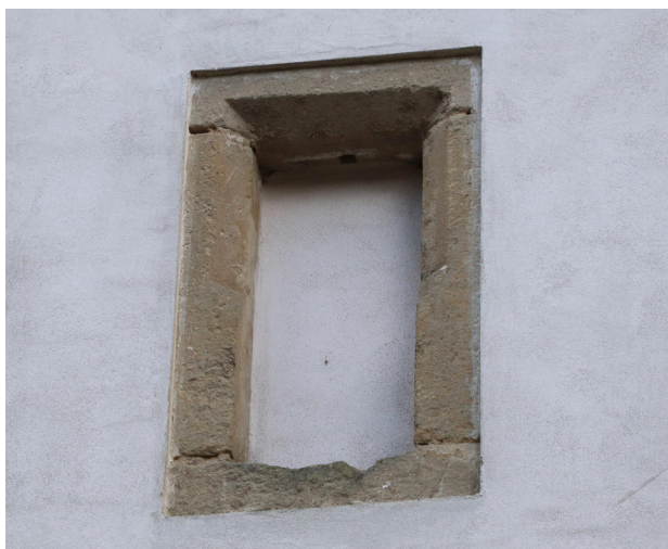
11) Detail okenního otvoru v 1. patře východního průčelí věže. Foto: Tomáš Brož 2021.
