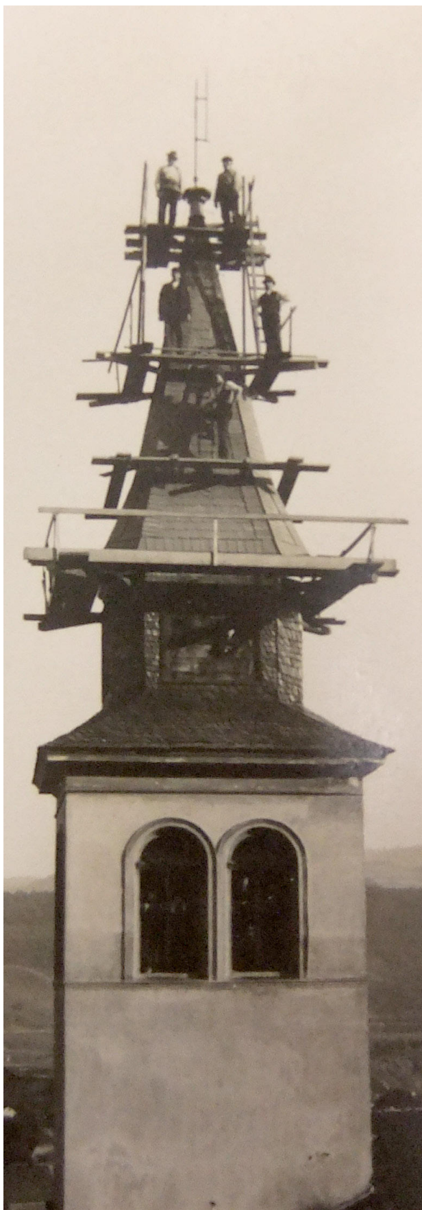
23) Fotografie z opravy střešní krytiny věže v roce 1925 (AM Ústí nad Labem, AO Mojžíř, fotografická příloha obecní kroniky).
