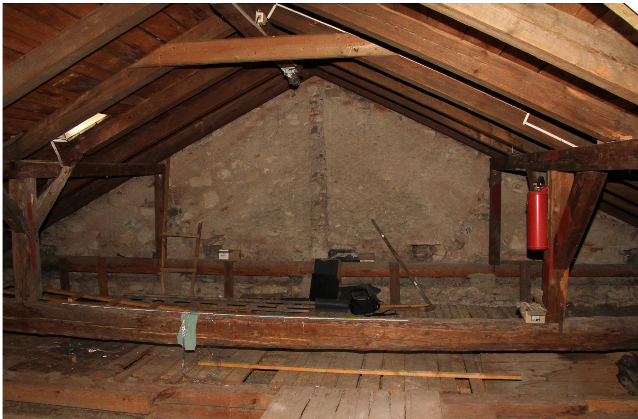
20) Rubová strana štítové stěny předsíně s otiskem původního krovu z roku 1846, který byl v roce 1863 nahrazen současnou konstrukcí. Foto: Jaroslav Skopec 2021.
