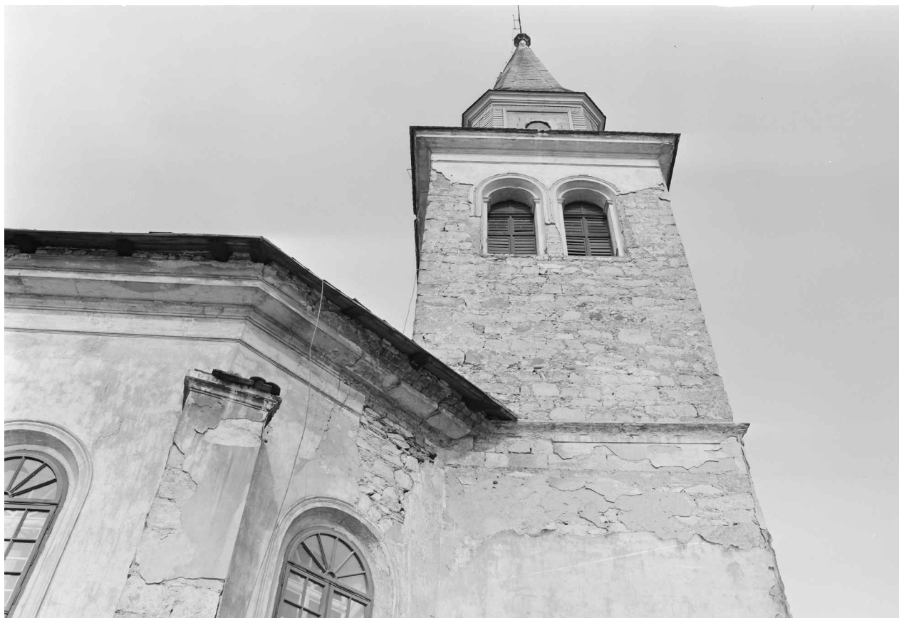
13) Jižní průčelí věže a jihovýchodní průčelí presbytáře před opravou omítek, pohled od jihu. Foto: Roman Kursa 1993.
