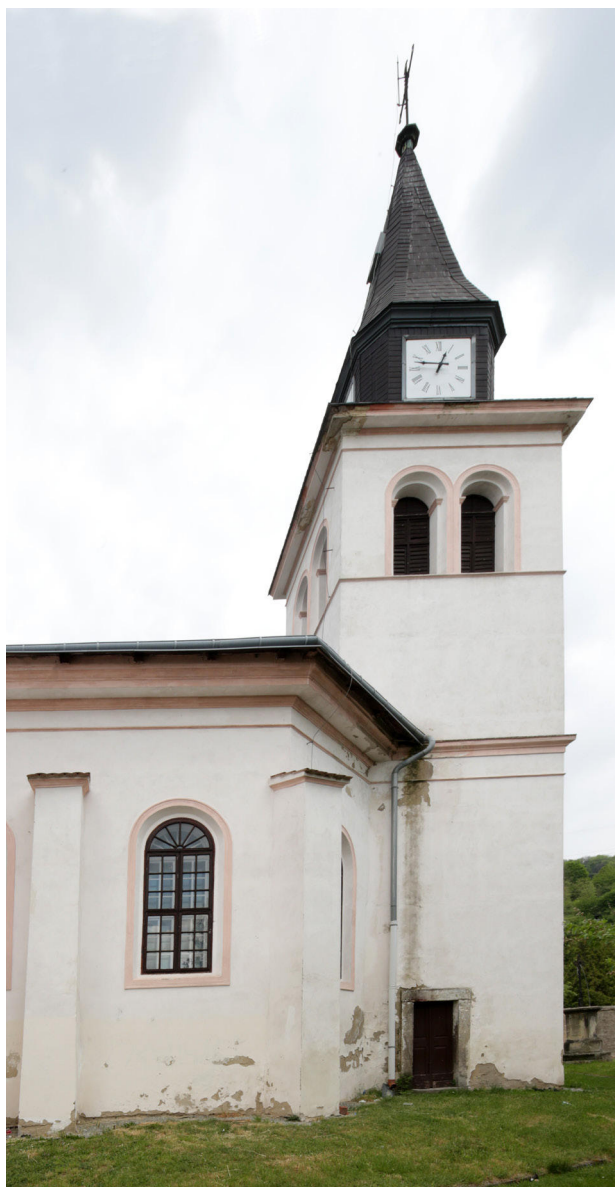
2) Jižní průčelí presbytáře a věže, pohled od jihu. Foto: Marta Pavlíková, 2020.
