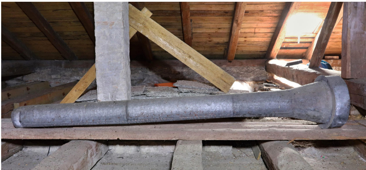
21) Dochovaná část komínku odvzdušnění kostela. Foto: Tomáš Brož 2021.
