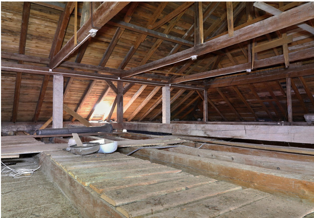
10) Krov lodi, pohled od severovýchodu. Foto: Tomáš Brož 2021.
