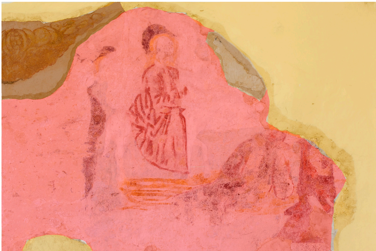
2a) Kostel sv. Máří Magdaleny, Zubrnice. Severní stěna lodi. Barokní (?) feston a Vjezd Krista do Jeruzaléma. Orientační grafické vyznačení jednotlivých vrstev omítek. Žlutá: poslední vrstva, hnědá: barokní (?) vrstva, červená: středověká vrstva. Foto: NPÚ ÚOP v Ústí nad Labem, Kateřina Neumannová, 2012.
