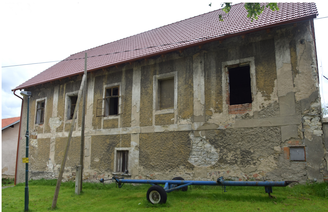
3) Současný stav hospodářských budov v areálu hospodářského dvora v Žerotíně. Pohled na objekt, který můžeme ztotožnit se sušárnou chmele na plánech z roku 1885, uliční průčelí. Foto: Lucie Radová.
