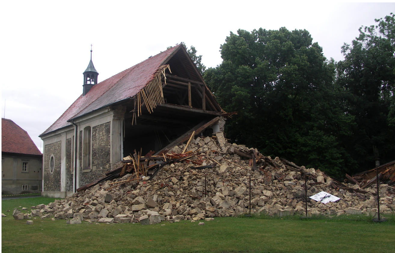
Obr. 2. Lenešice, kostel sv. Šimona a Judy, havárie věže a západní průčelí, celkový pohled od SZ. Foto: Jiří Bureš, 23. 9. 2008.
