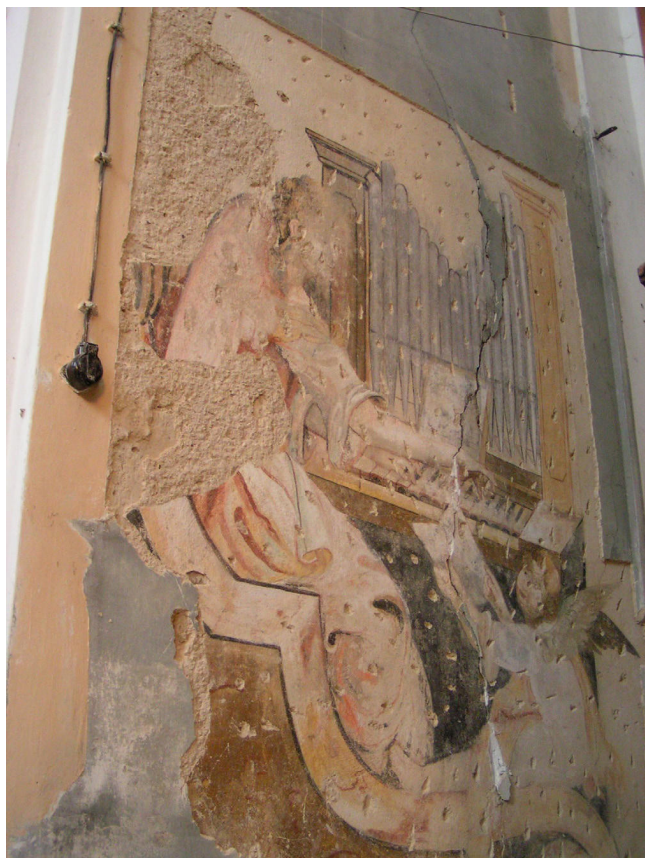
Obr. 8. Kostomlaty pod Milešovkou, kostel sv. Vavřince, detail nástěnné malby za bočním oltářem Pražského Jezulátka (po odkryvu a konsolidaci). Foto: Vít Honys.
