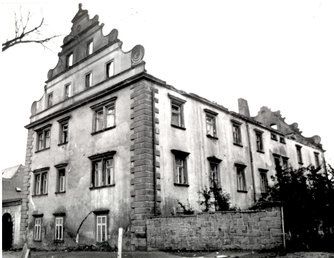
Obr. 2. Šluknov, zámek, pohled od jihozápadu, stav po požáru 1. 4. 1986, duben 1986. Foto: Lída Skokanová.
