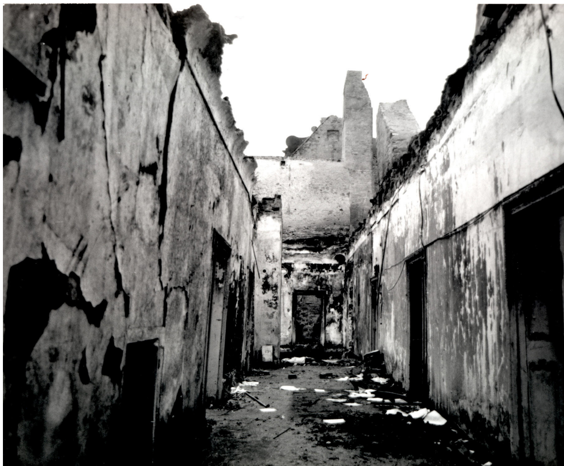
Obr. 8. Šluknov, zámek, 2. patro, chodba, stav po požáru 1. 4. 1986, duben 1986. Foto: Lída Skokanová.
