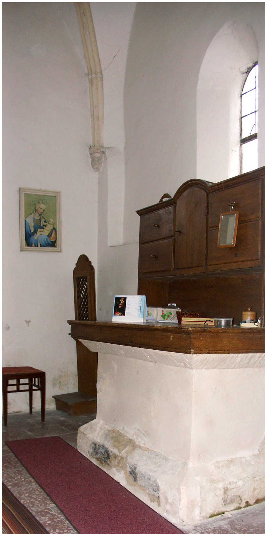
Obr. 13. Sulejovice, kostel Nejsvětější Trojice, východní stěna sakristie v pohledu od jihovýchodu. Foto: Jaroslav Skopec, 2009.
