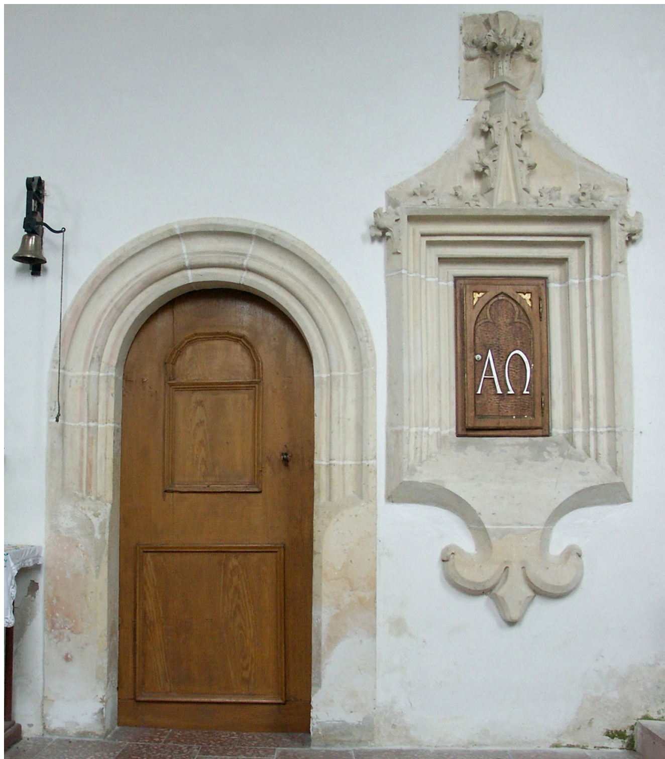
Obr. 11. Sulejovice, kostel Nejsvětější Trojice, sanktuárium a portál vstupu do sakristie v severní stěně presbytáře v pohledu od jihu. Foto: Jaroslav Skopec, 2009.
