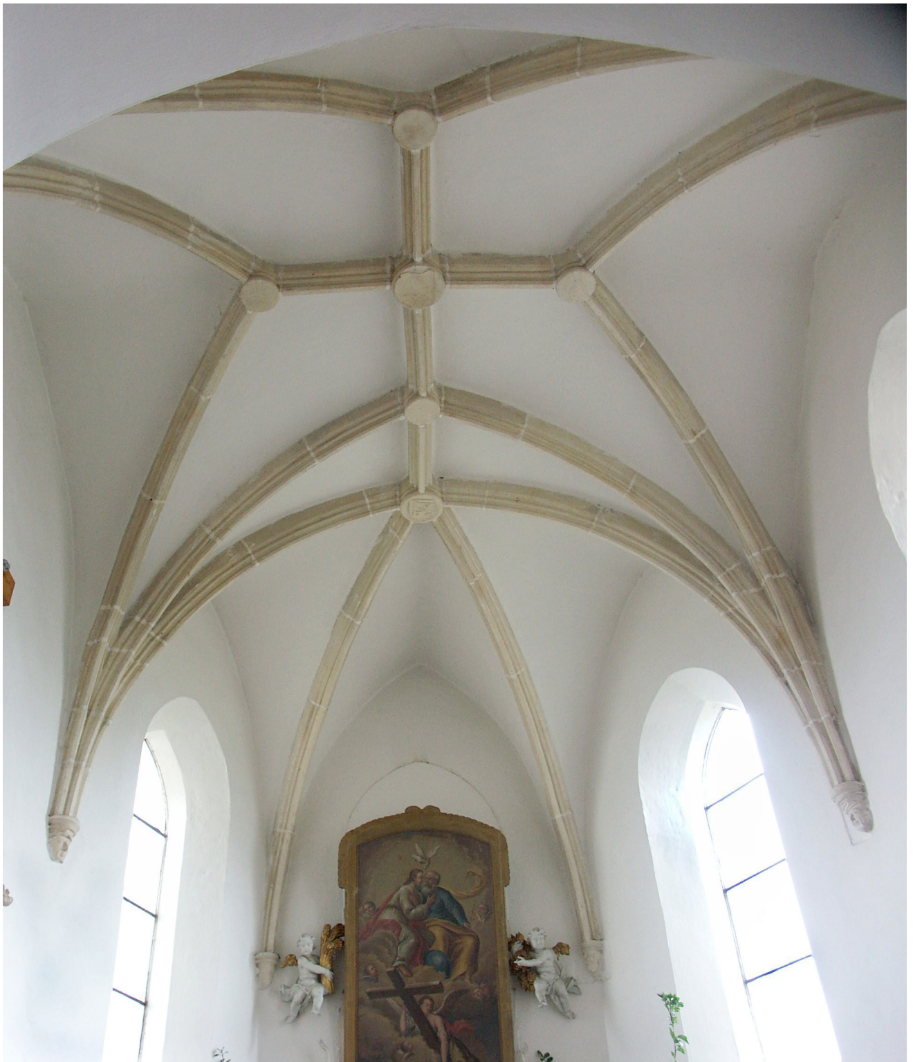
Obr. 12. Sulejovice, kostel Nejsvětější Trojice, klenba presbytáře v pohledu od západu. Foto: Jaroslav Skopec, 2009.
