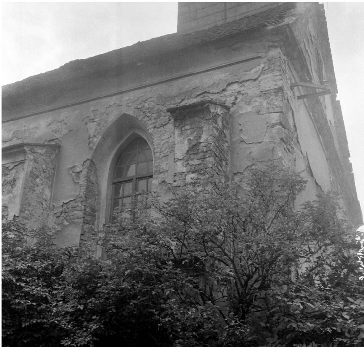
Obr. 18. Severozápadní nároží lodi, pohled od severozápadu, inv. č. negativu 18326. Foto: NPÚ ú. o. p. Ústí nad Labem, 1965.
