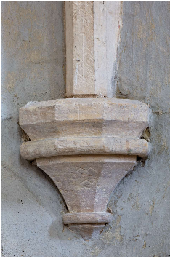
Obr. 11. Detail severní konzole presbytáře. Foto: Kateřina Neumannová, 2016.
