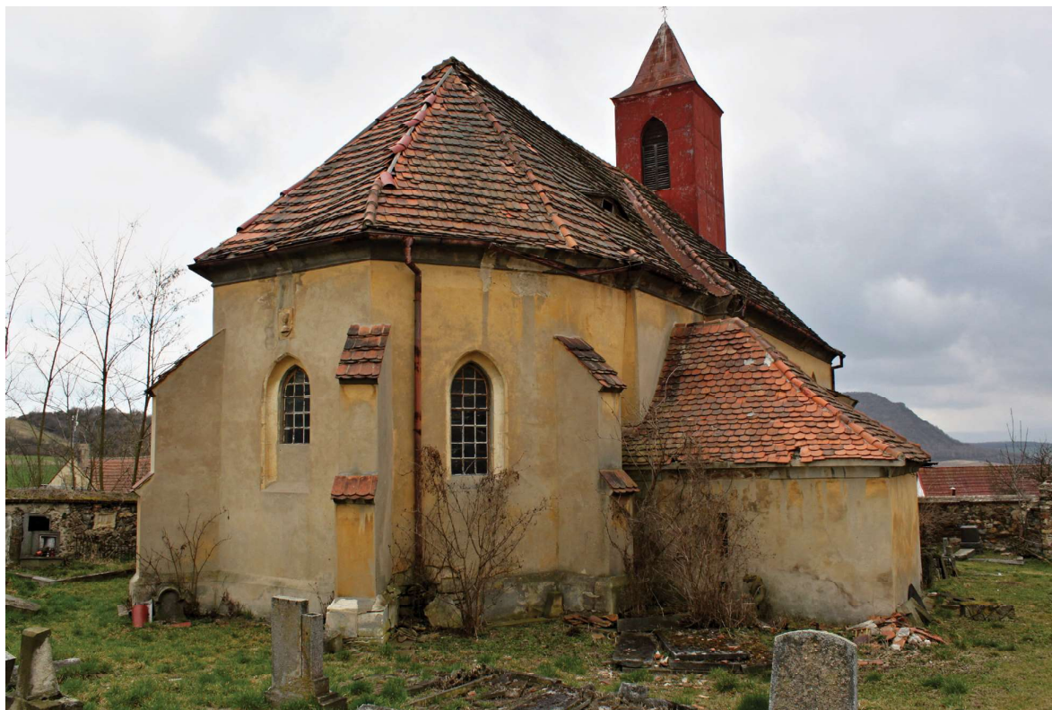
Obr. 1. Celkový pohled od severovýchodu. Foto: Tomáš Brož, 2016.
