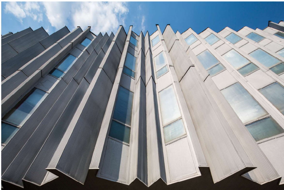
Obr. 8. Detail fasády, archiv NPÚ u. o. p. Ústí nad Labem. Foto: Marta Pavlíková, 2015.
