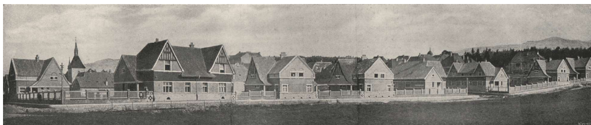
Obr. 5. Kolonie U Černé Matky Boží krátce po dostavbě, zdroj: Jindřich Freiwald, Naše stavby , 1921.
