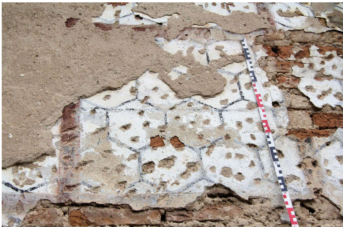
Obr. 12. Zahorany, kostel Nejsvětější Trojice, západní průčelí, detail jednoho pole iluzivní terčíkové okenní výplně zazdívkou okna s rytou a malovanou pásovinou a malovanými šestihrany. Foto: Táňa Šimková, 2015.
