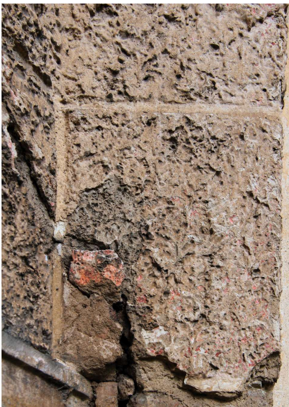
Obr. 7. Zahořany, kostel Nejsvětější Trojice, jižní bok presbytáře s dobře patrným kontrastním řešením struktury spár a iluzivního kvádrování s reliktem souvislé vrstvy raně barokní červené barevnosti na ploše iluzivního kvádrů. Foto: Táňa Šimková, 2014.
