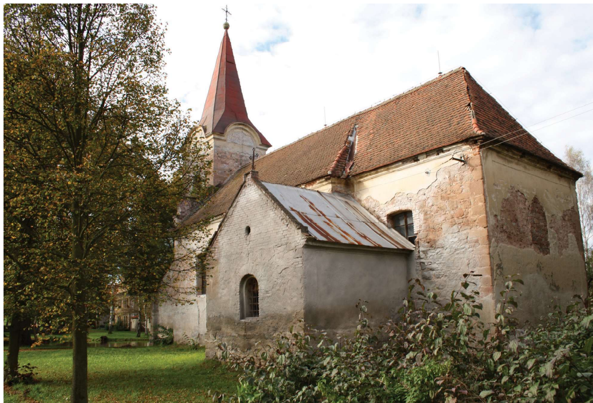
Obr. 1. Celkový pohled od jihovýchodu. Foto: Jaroslav Skopec, 2014.
