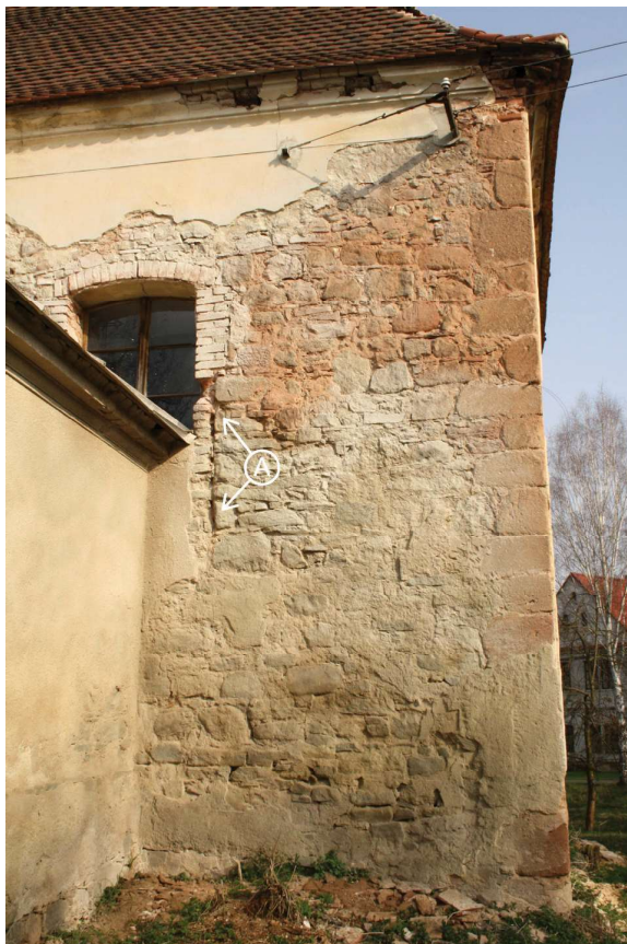
Obr. 22. Pohled na východní polovinu jižního průčelí presbytáře. A – spára mezi cihelnou obezdívku stávajícího okenního otvoru a zalícovaným kamenným zdivem presbytáře, které naznačuje možnost existence středověkého okenního otvoru. Foto: Jaroslav Skopec, 2014.
