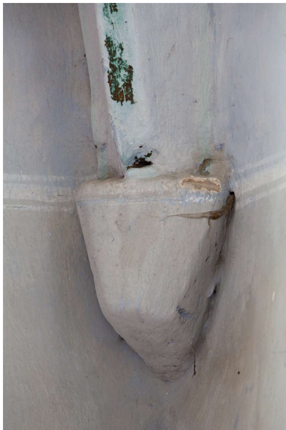
Obr. 12. Detail jihovýchodní konzole klenby presbytáře. Foto: Kateřina Neumannová, 2016.
