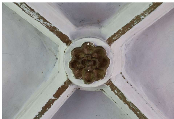
Obr. 11. Detail svorníku klenby presbytáře. Foto: Kateřina Neumannová, 2016.
