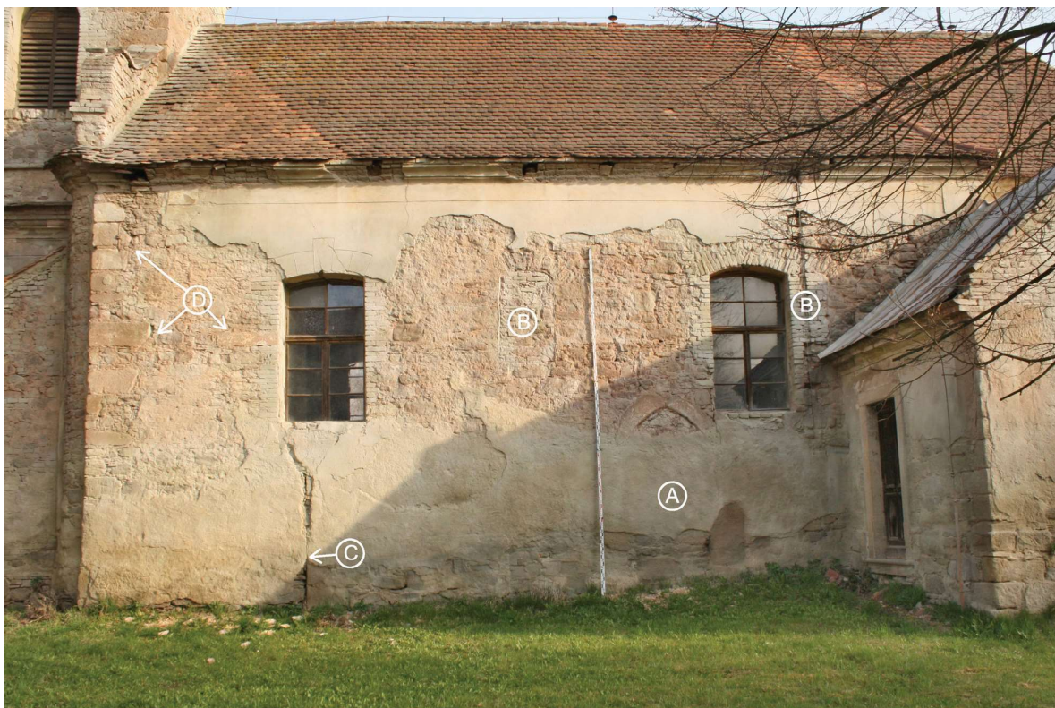
Obr. 17. Čelní pohled na jižní průčelí lodi. A – středověký portál zazděný při rozšíření lodi roku 1788. B – dvojice středověkých okenních otvorů zazděných při rozšíření lodi a realizaci stávajících okenních otvorů roku 1788. C – vertikální spára určující původní délku středověké lodi, v patě jsou dochovány kvádry nárožního armování. D – středověké kvádry druhotně použité při prodloužení lodi v roce 1788. Foto: Jaroslav Skopec, 2014.
