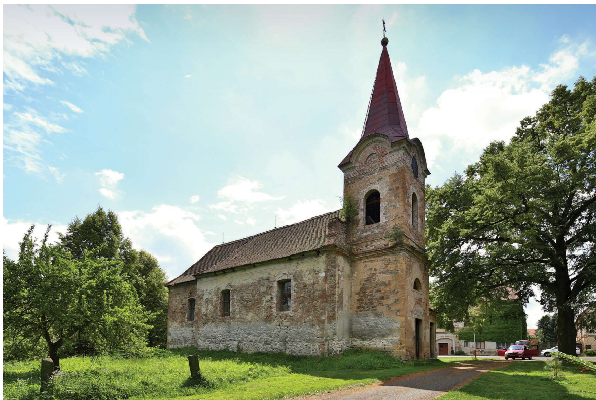
Obr. 2. Celkový pohled od severozápadu. Foto: Kateřina Neumannová, 2016.
