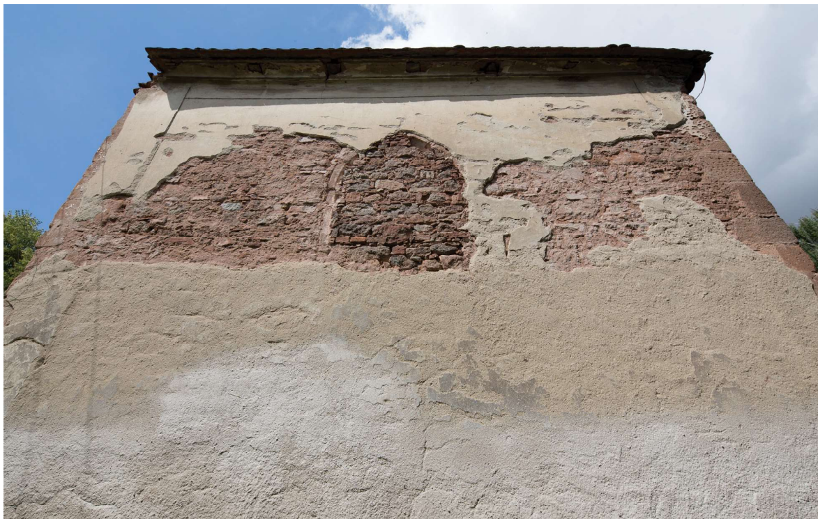
Obr. 21. Pohled na východní průčelí presbytáře se zazděným středověkým okenním otvorem. Foto: Kateřina Neumannová, 2016.
