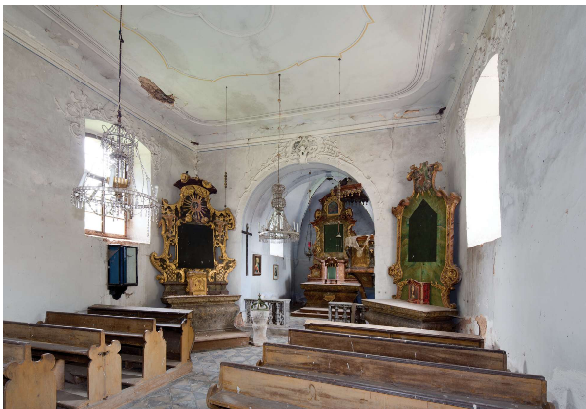
Obr. 8. Pohled do interiéru lodi směrem k východu. Foto: Kateřina Neumannová, 2016.
