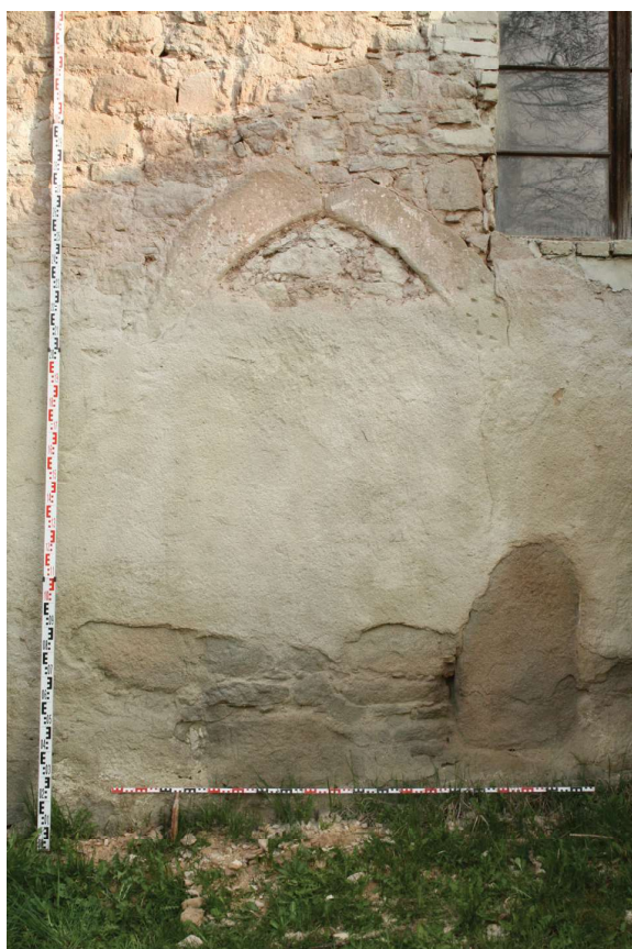
Obr. 18. Detail zazděného středověkého portálu na jižní straně lodi. Foto: Jaroslav Skopec, 2014.
