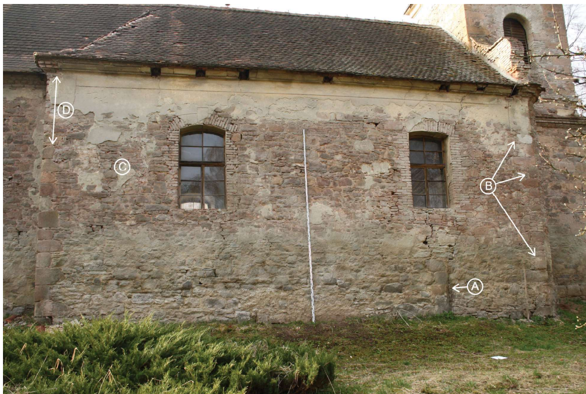
Obr. 20. Čelní pohled na severní průčelí lodi. A – vertikální spára určující původní délku středověké lodi s dochovanými kvádry spodní partie nárožního armování. B – středověké kvádry druhotně použité při prodloužení lodi v roce 1788. C – zadržný okenní otvor pocházející z blíže neurčitelné doby před rozšířením lodi roku 1788. D – přezděné nároží související patrně s rozšířením lodi roku 1788. Foto: Jaroslav Skopec, 2014.
