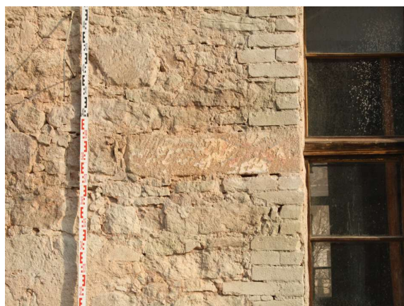
Obr. 19. Detail středověkého kvádry s okosenou hranou a polychromií, který byl druhotně osazen do západní špalety západního okenního otvoru jižní strany lodi. Foto: Jaroslav Skopec, 2014.
